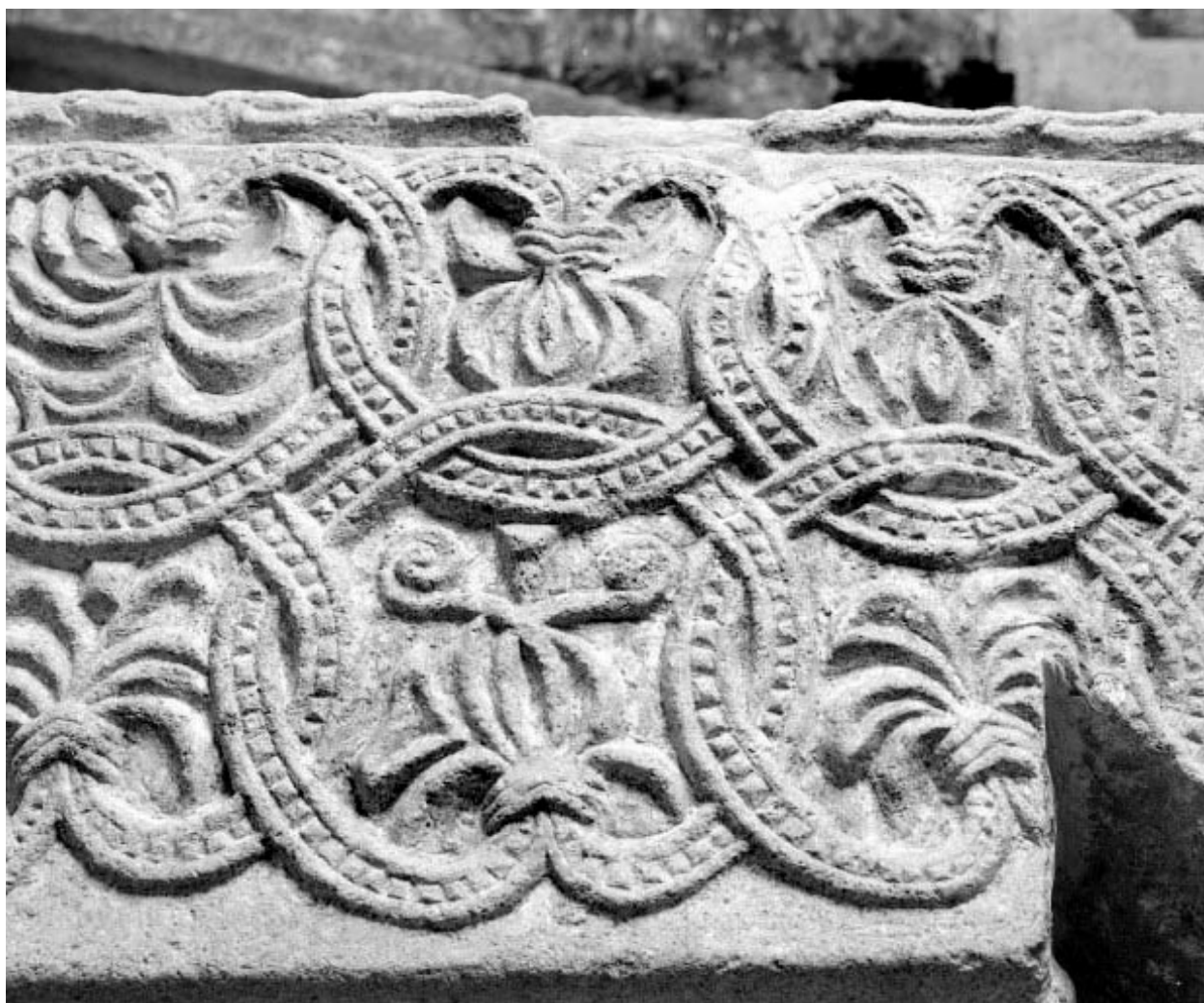
Détail du toit en batière.
