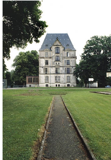
Façade depuis l'ouest. Phot. Yves Sancey IVR43_20009000458ZA
