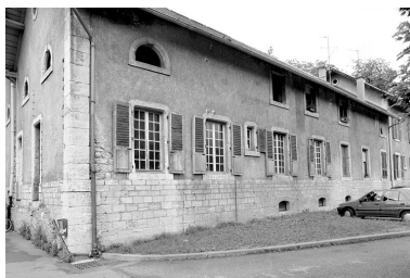
Façade est des écuries. Phot. Yves Sancey IVR43_20009000475X
