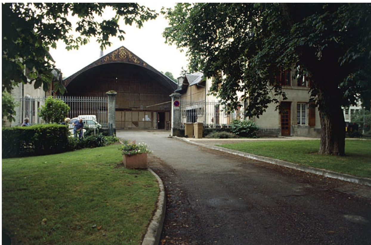
Les écuries depuis le nord.
