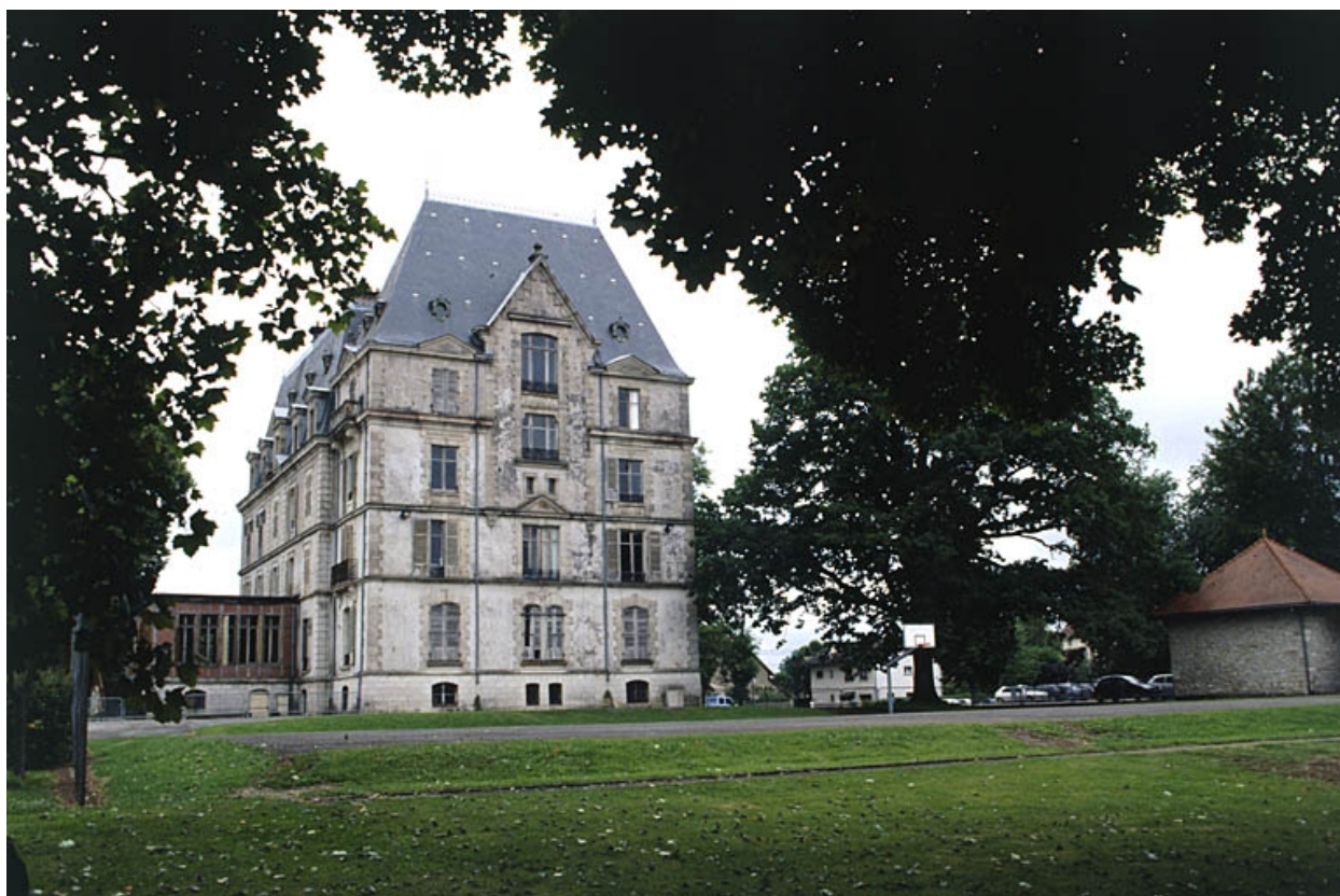
Façade ouest vue de trois quarts gauche.
