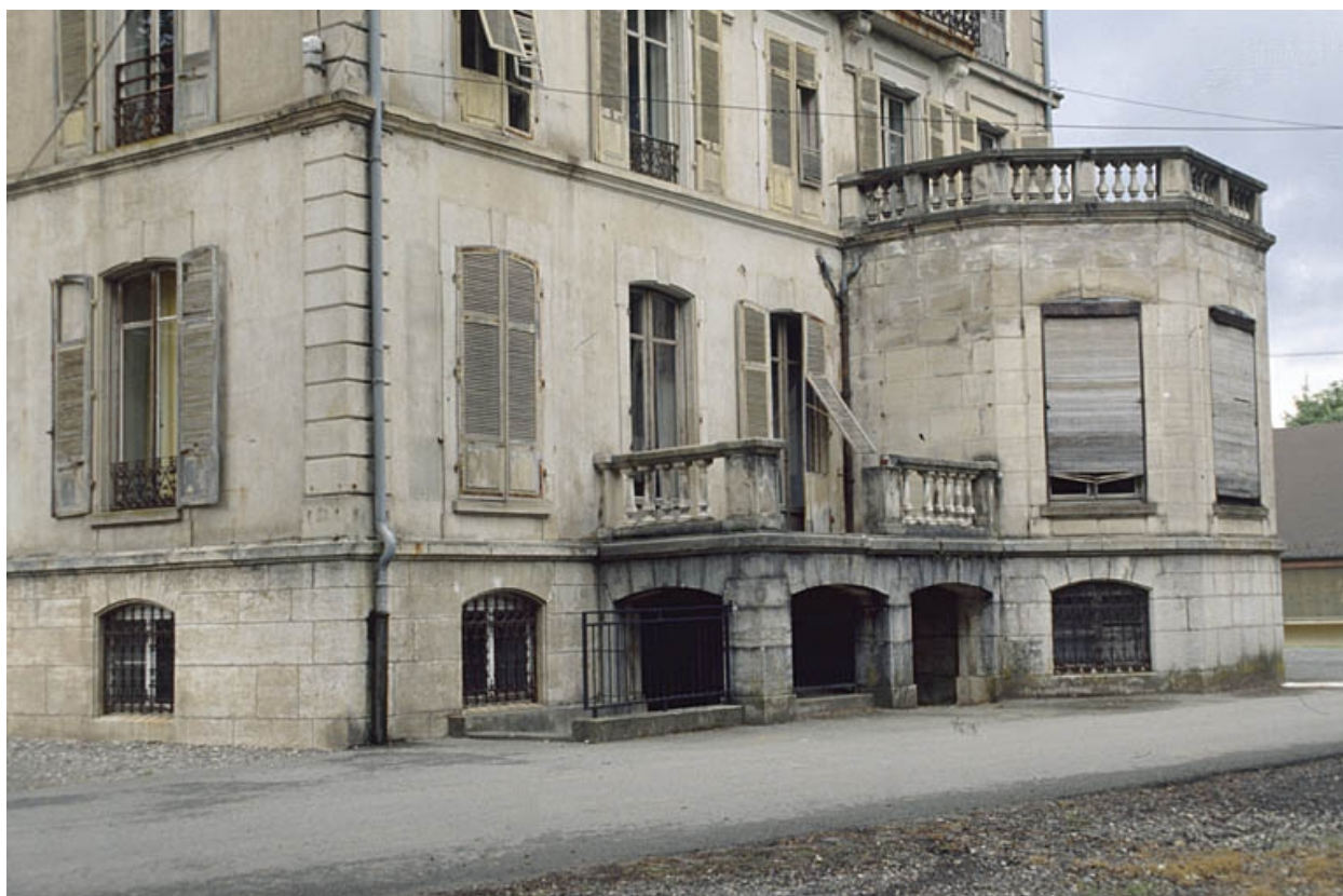
Détail de la façade est.
