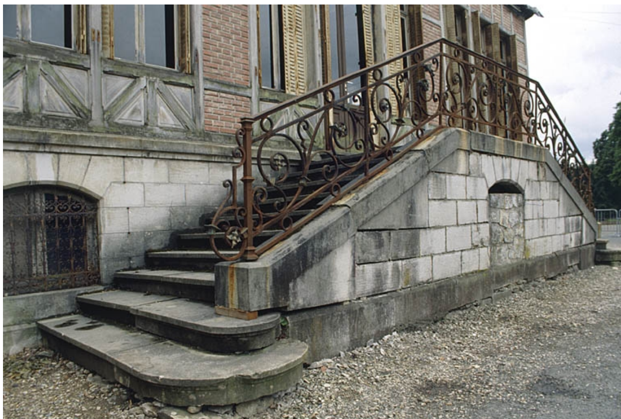
Détail de l'escalier de la façade postérieure.
