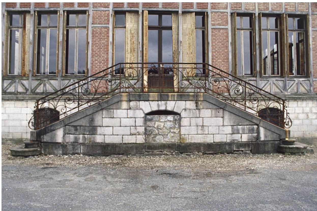
Escalier sur la façade postérieure.
