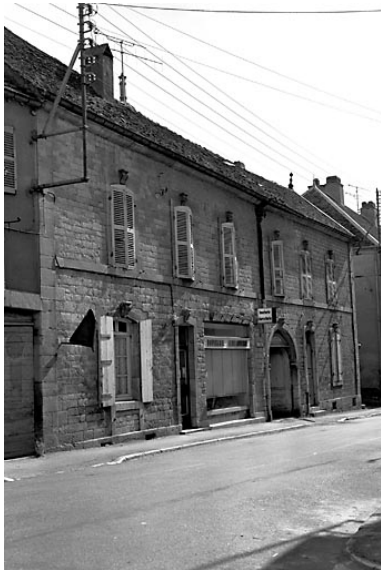
Façade antérieure en pierre de taille : vue de trois quarts gauche. Phot. Dominique Dominguez IVR43_19807000512X
