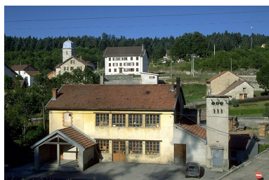
Façade antérieure. Phot. Laurent Poupard IVR43_19913901239ZA
