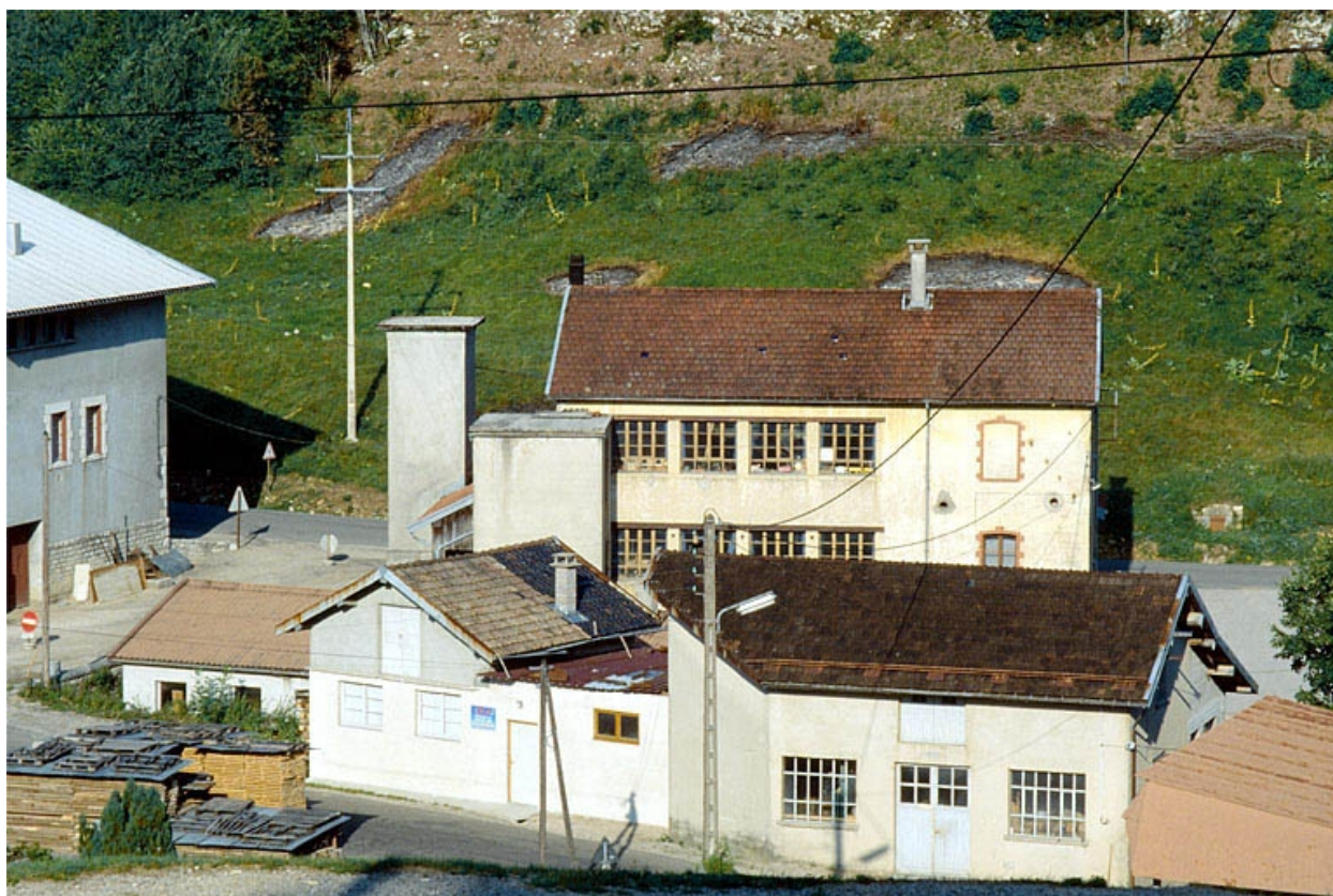
Façade postérieure vue de trois quarts droite.
