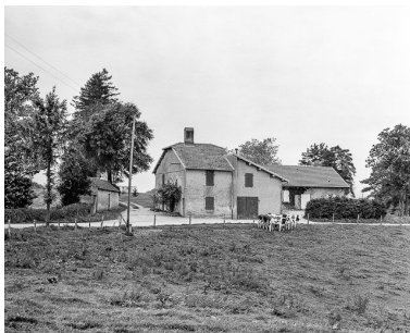
Habitation située à l'entrée de la propriété. Phot. Bernard Lardière IVR43_19807000272X
