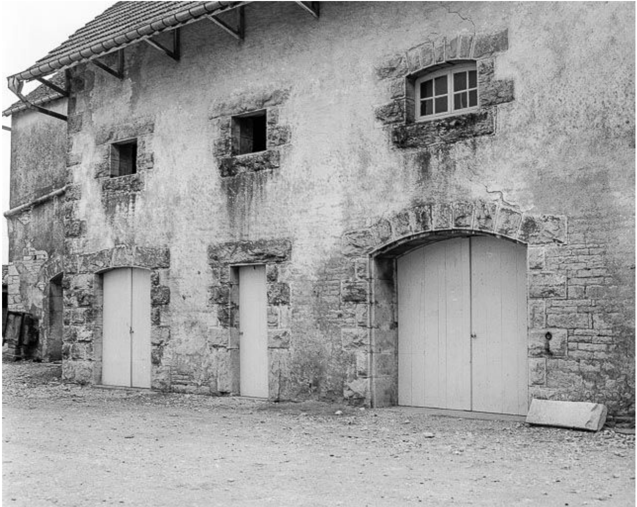
Partie agricole : détail de la façade postérieure.
