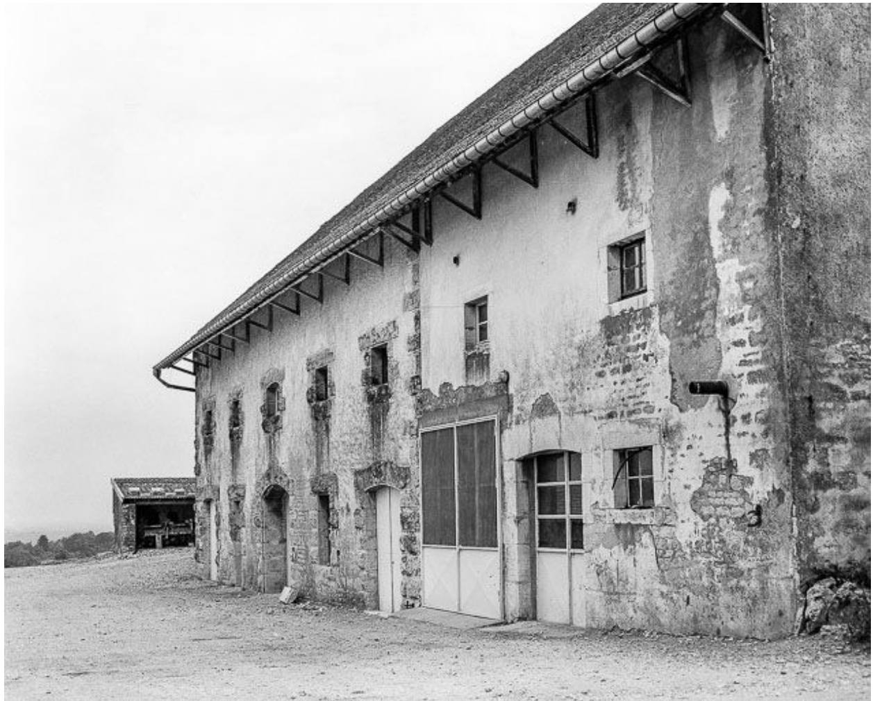
Partie agricole : façade postérieure.
