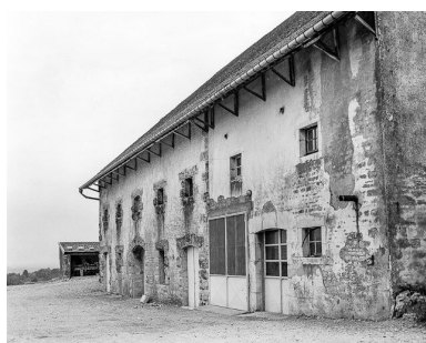
Partie agricole : façade postérieure. Phot. Dominique Dominguez IVR43_19807000276X
