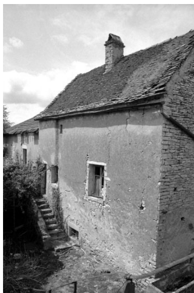
Habitation sur cave dans la cour, avec escalier extérieur. Phot. Bernard Lardière IVR43_19817000537Z
