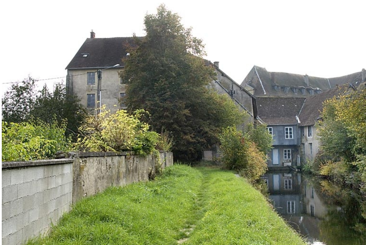
Façade postérieure depuis l'amont du bief.
