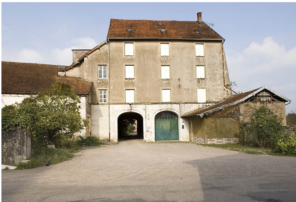
Façade antérieure vue de face.
