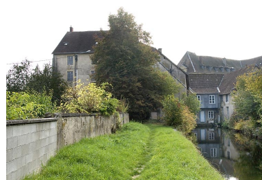
Façade postérieure depuis l'amont du bief. Phot. Jérôme Mongreville IVR43_20077000578NUCA
