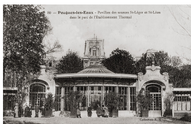
Façade ouest. Autr. auteur inconnu IVR26_20195800755NUC4A
