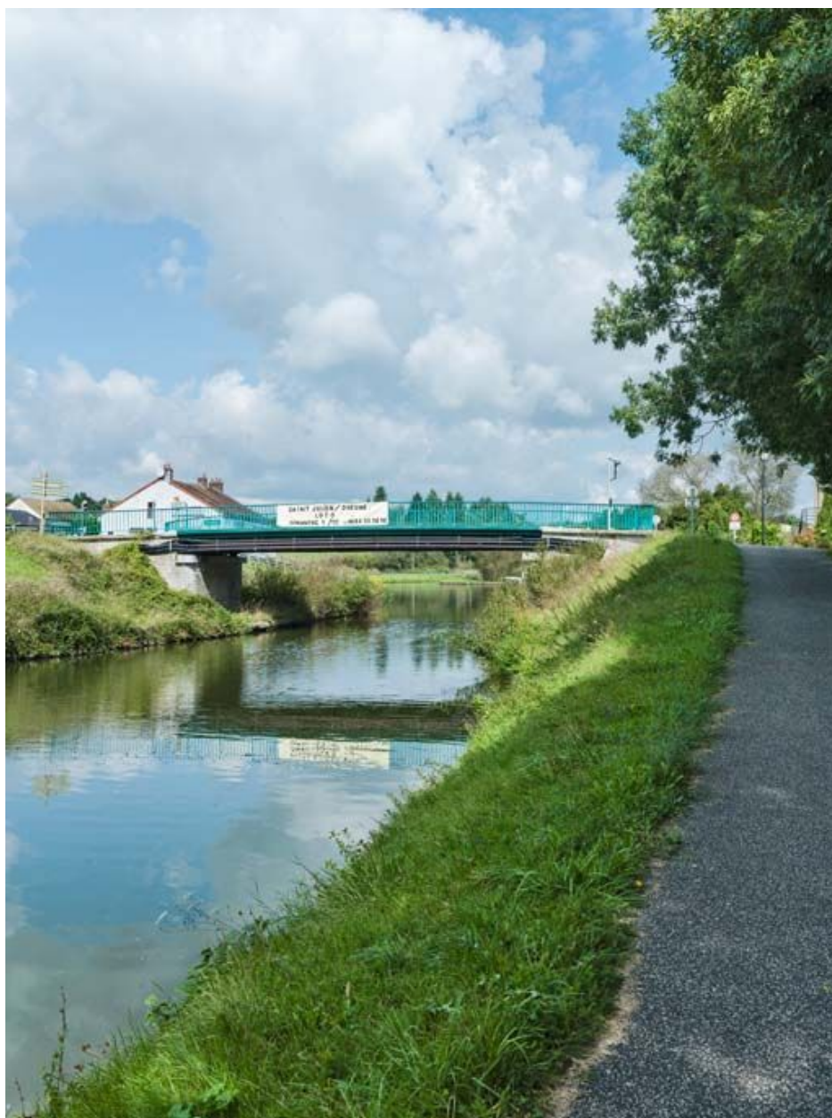
Vue d'ensemble du pont.
