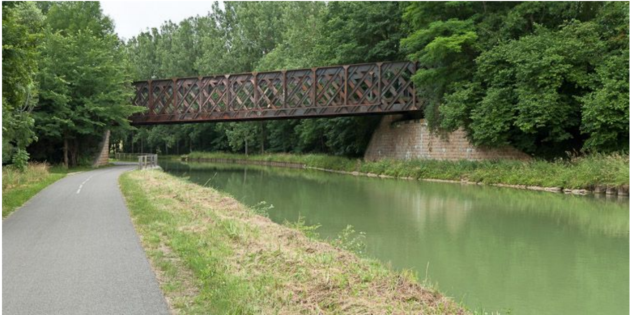
Vue d'ensemble du pont ferroviaire.
