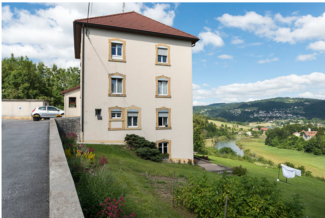
Façade latérale droite.
