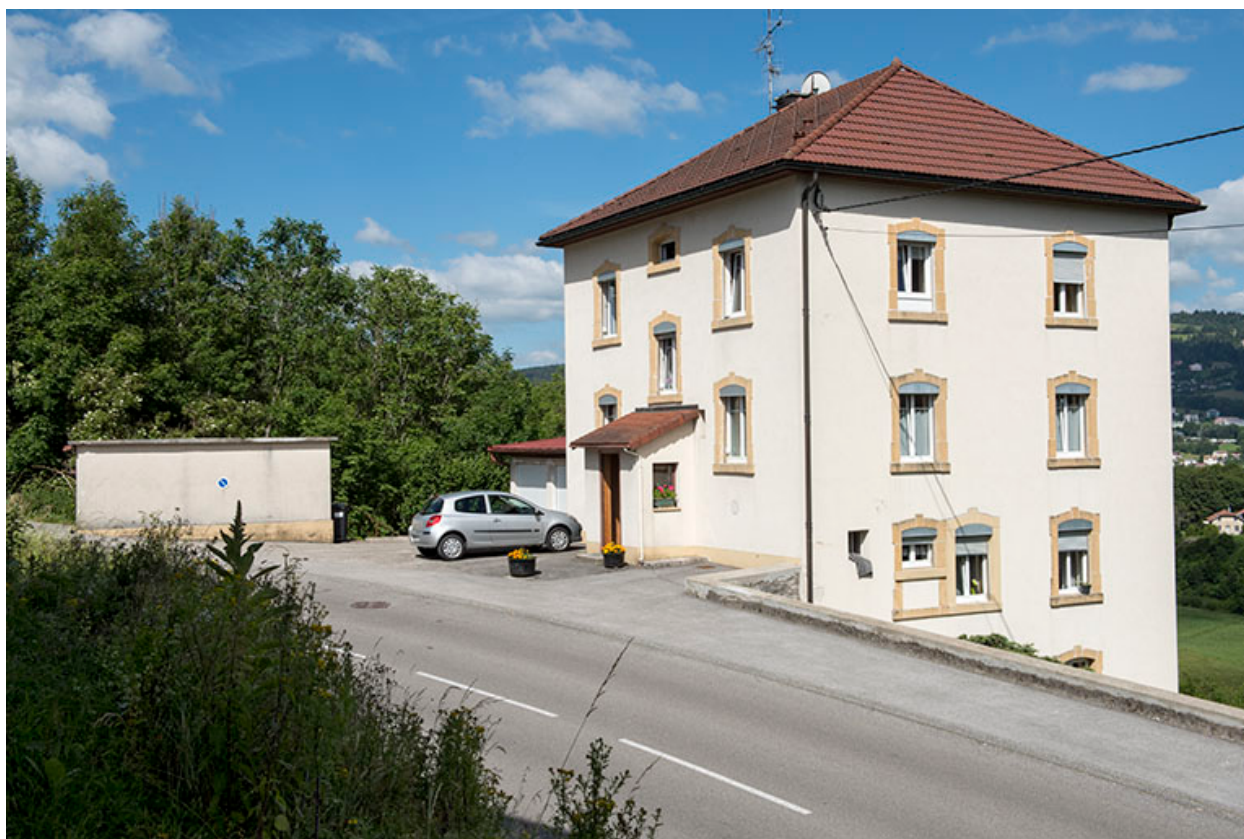
Façades antérieure et latérale droite.
