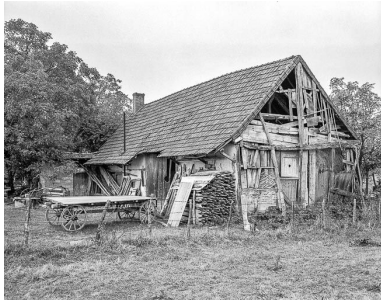
Façade antérieure et face droite.
