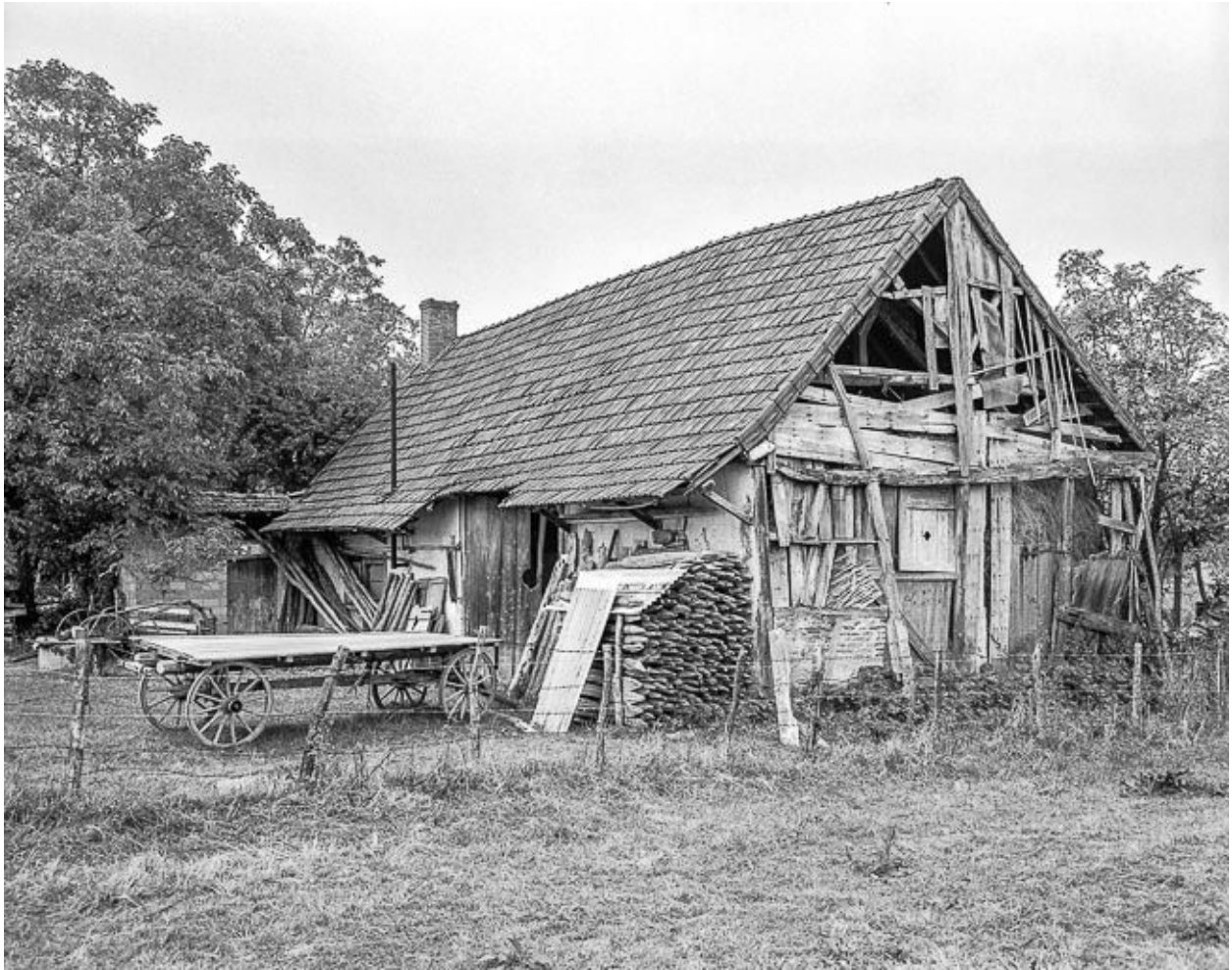
Façade antérieure et face droite.
