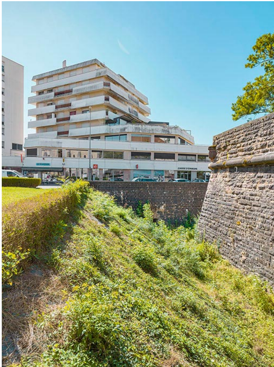
Le bastion Royal après restauration.
