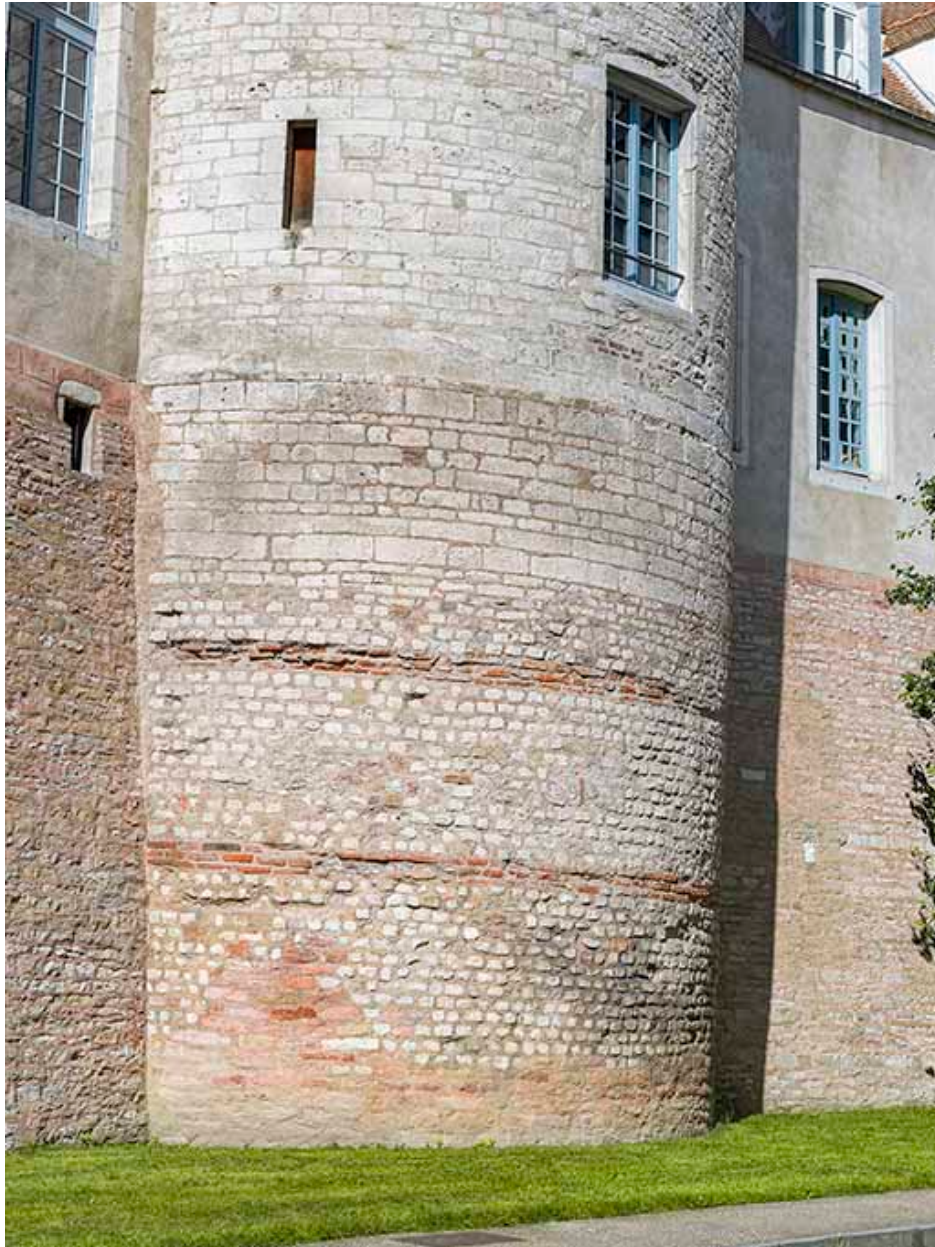
Détail de la maçonnerie, tour de l'Evêché.
