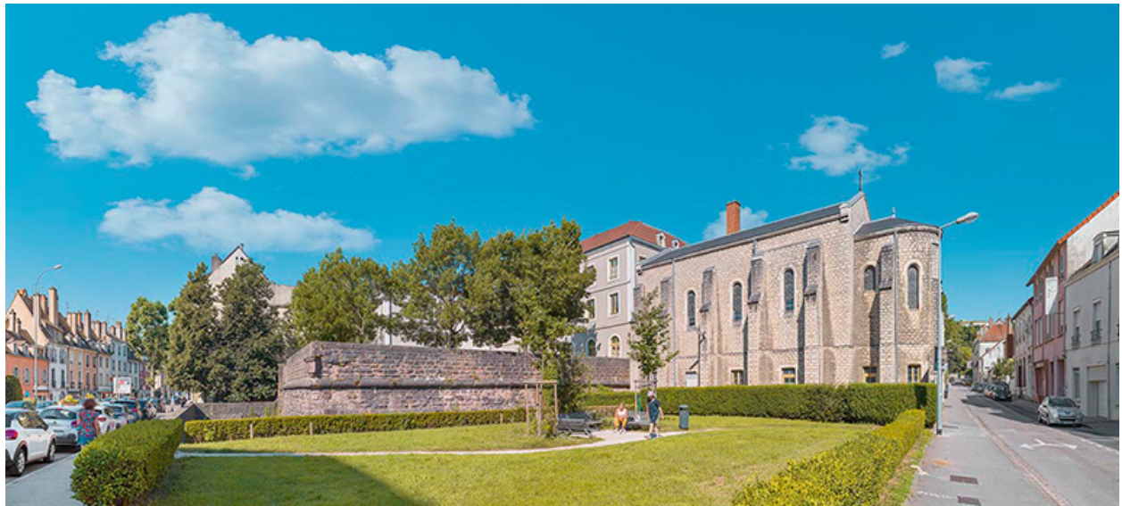
Vue générale du bastion Royal.
