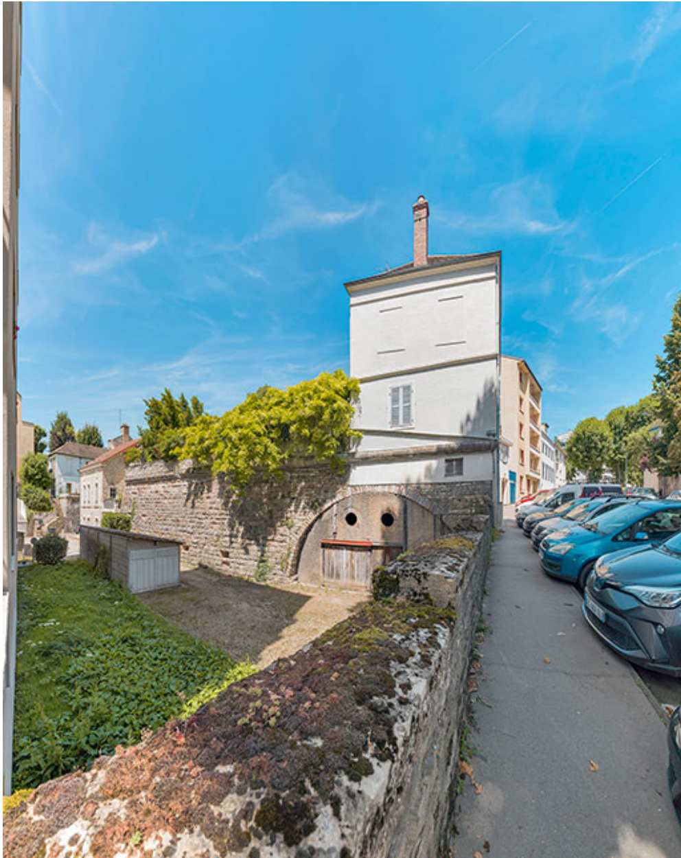
Flanc sud du bastion Saint-Paul.
