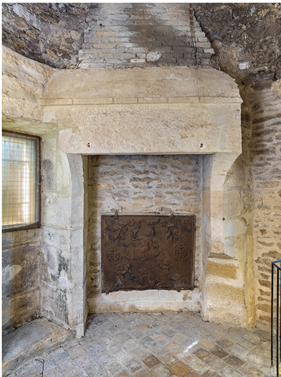
Cheminée de l'étage supérieur.
