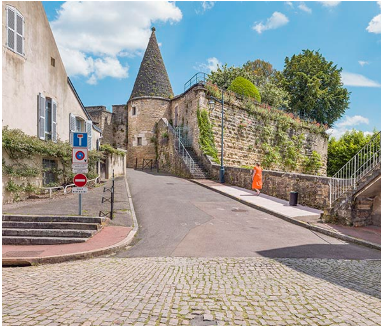
Vue depuis la rue Poterne.
