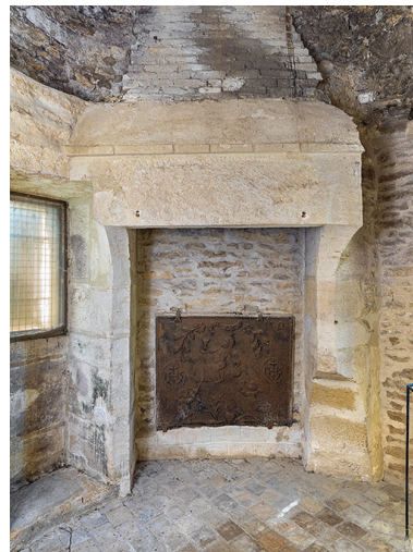
Cheminée de l'étage supérieur.
