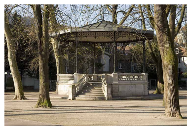
Kiosque : vue d'ensemble, de face. Phot. Jérôme Mongreville IVR43_20082500192NUC2A
