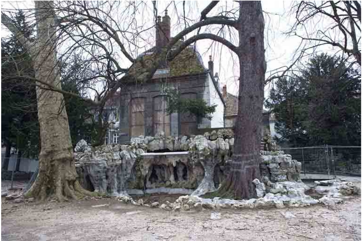
Vue d'ensemble de la grotte artificielle.
