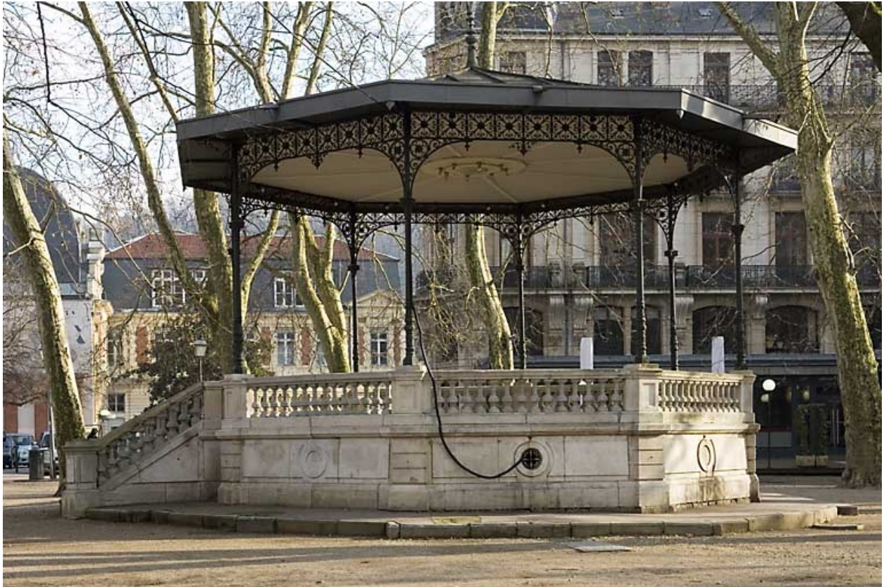
Vue d'ensemble du kiosque depuis la droite.
