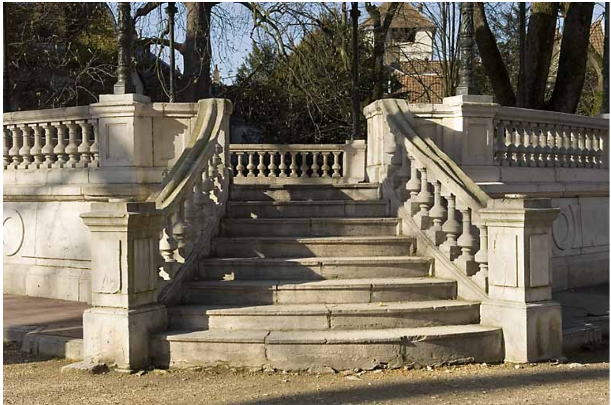
Kiosque : détail de la montée d'escalier.
