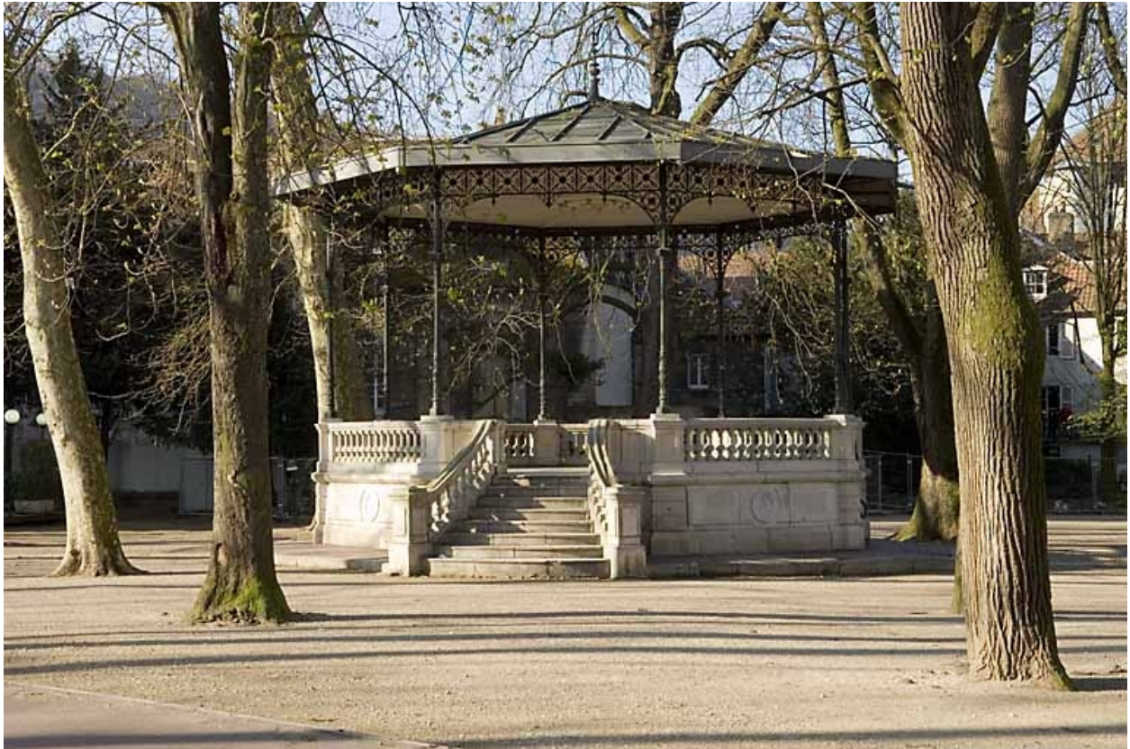
Kiosque : vue d'ensemble, de face.
