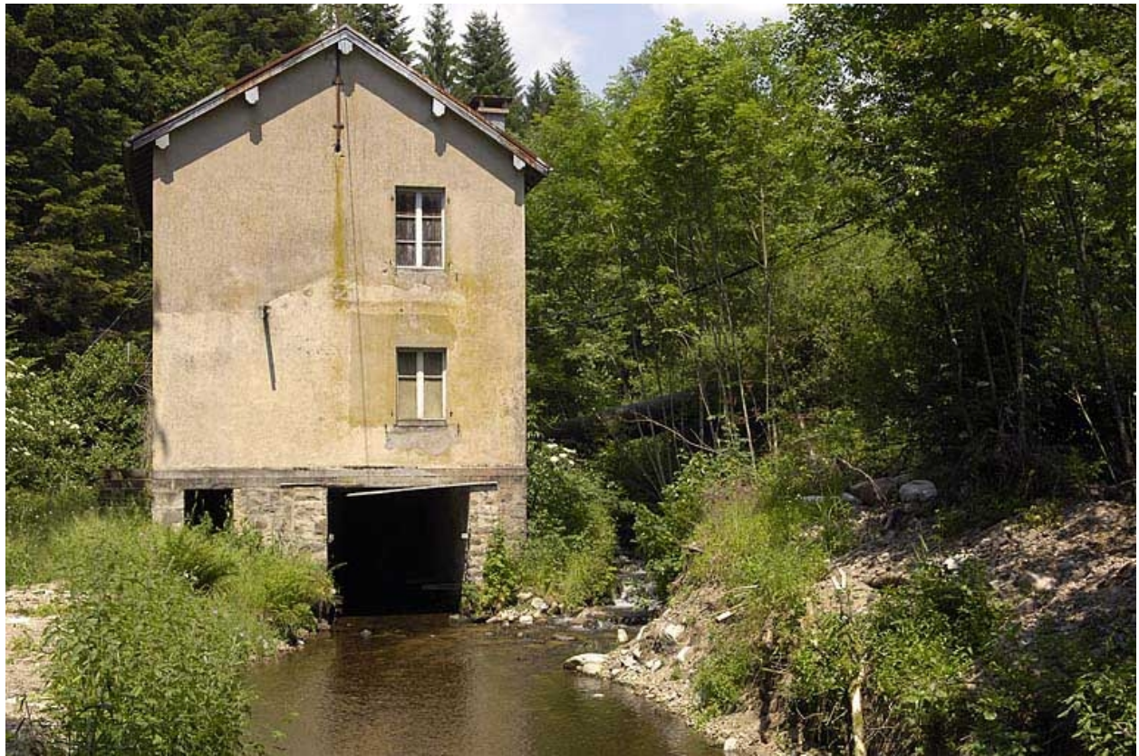
Vue depuis l'aval.
