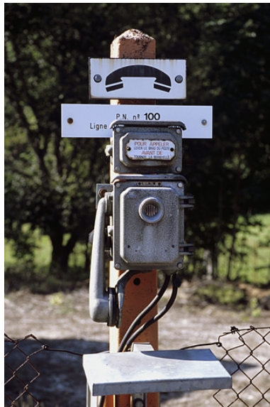
Téléphone de voie du passage à niveau n° 100. Phot. Yves Sancey IVR43_20050100108ZA
