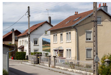
Vue d'ensemble des deux maisons semblables, aux n° 14 et 16 Rue Neuve. Phot. Sonia Dourlot IVR43_20142501884NUC2A
