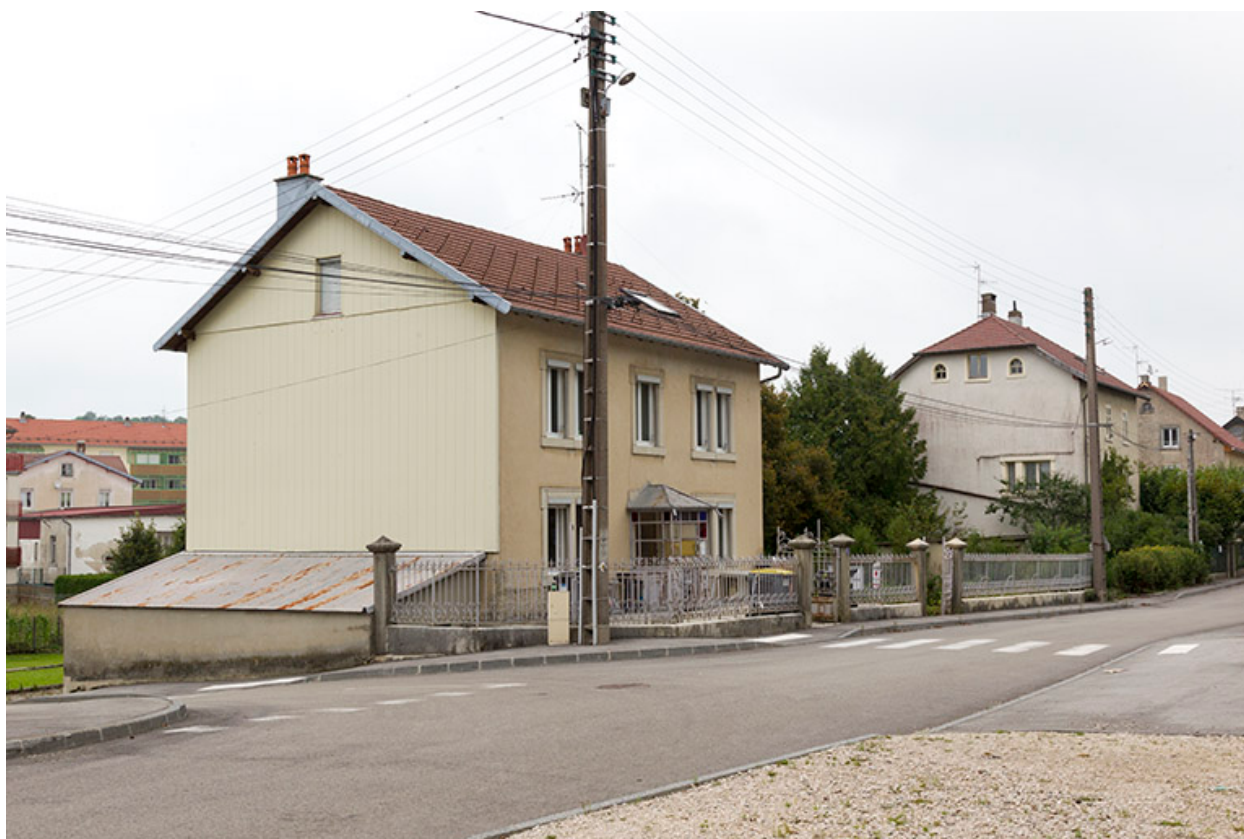
Façades antérieure et latérale gauche.
