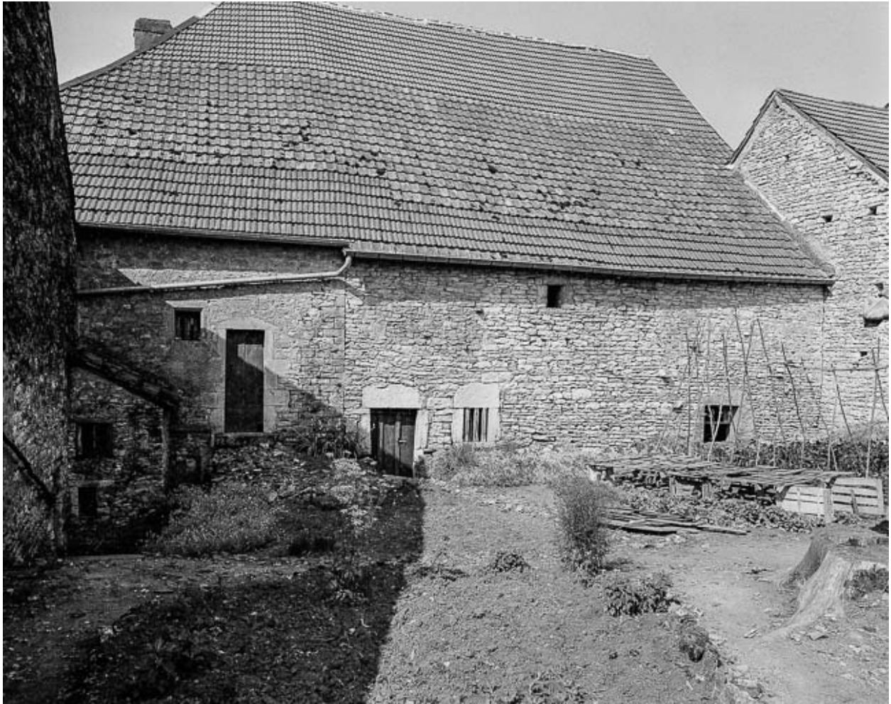
Façades postérieures (détail).
