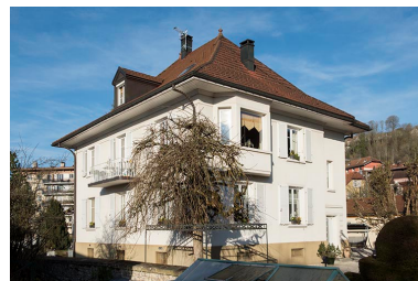
Maison-usine : élévations sud-est et nord-est.
