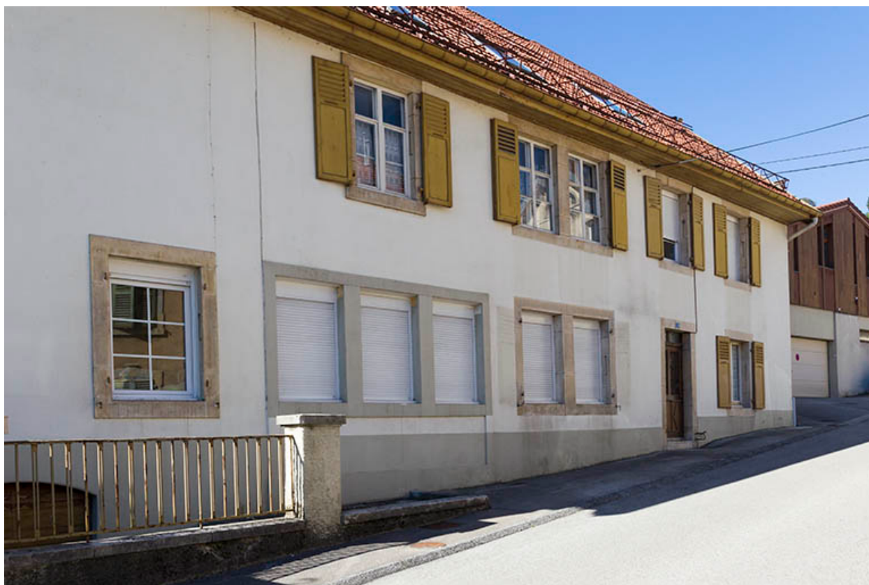
Ferme : façade antérieure, de trois quarts gauche.
