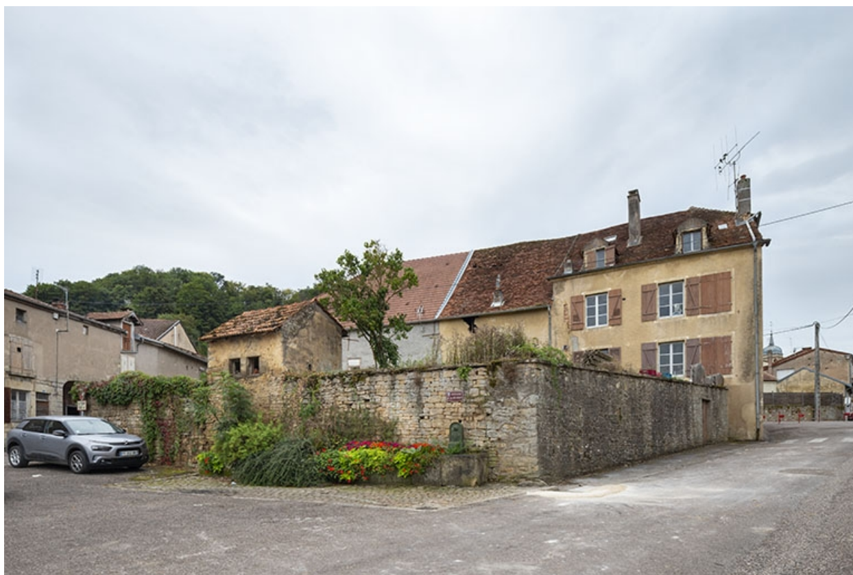
L'arrière de la maison.
