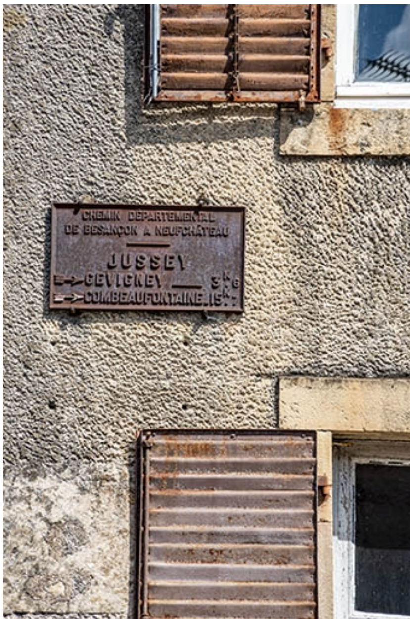
Détail de la façade avec plaque directionnelle.
