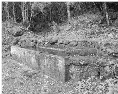
Le bassin vu de trois quarts. Phot. Jérôme Mongreville IVR43_19963901033X
