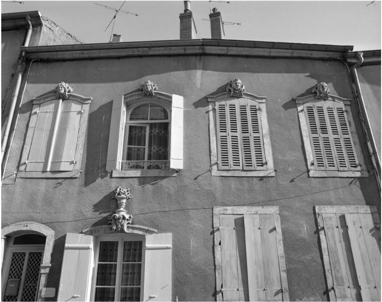
Façade antérieure : baies du premier étage.
