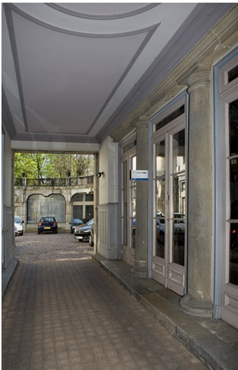
Vue d'ensemble du passage cocher depuis l'entrée.
