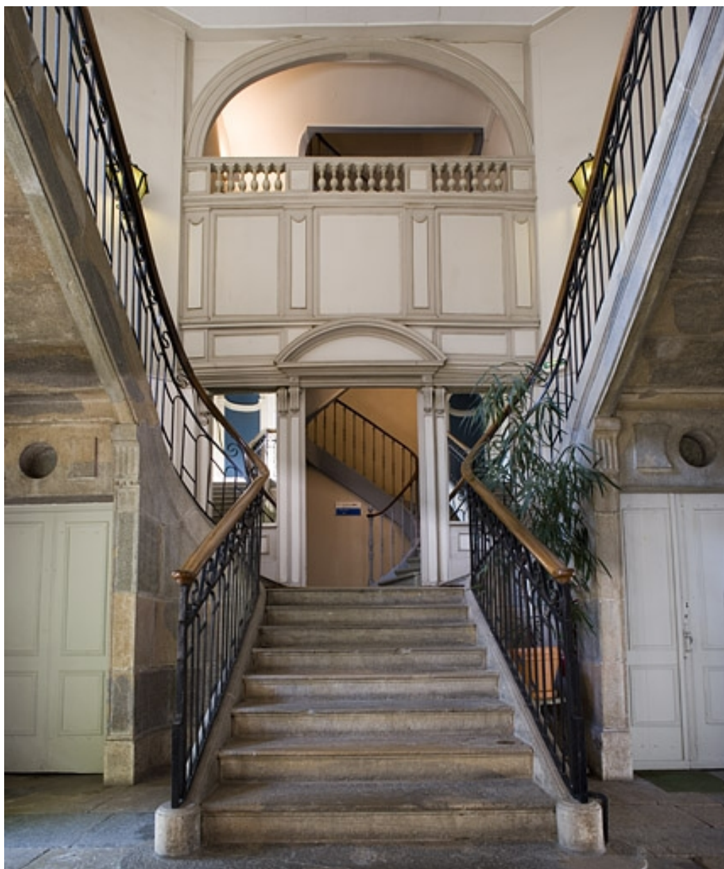
Vue de l'escalier d'honneur de face.
