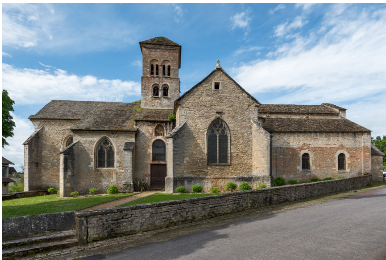
Flanc nord (vue depuis le nord).
