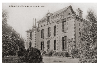
Façade nord-est. Phot. auteur inconnu IVR26_20195800740NUC4A
