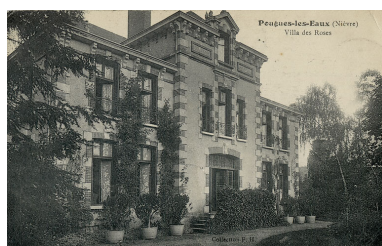
Façade sud-ouest. Autr. auteur inconnu IVR26_20205800363NUC4A
