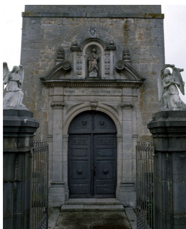
Portail et grille d'entrée. Phot. Yves Sancey IVR43_19903901175XA
