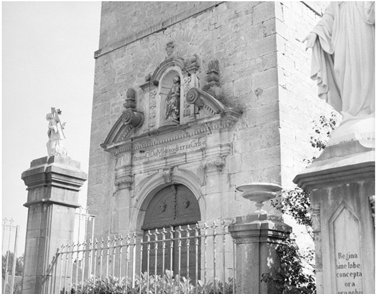
Façade antérieure, portail, partie supérieure.
