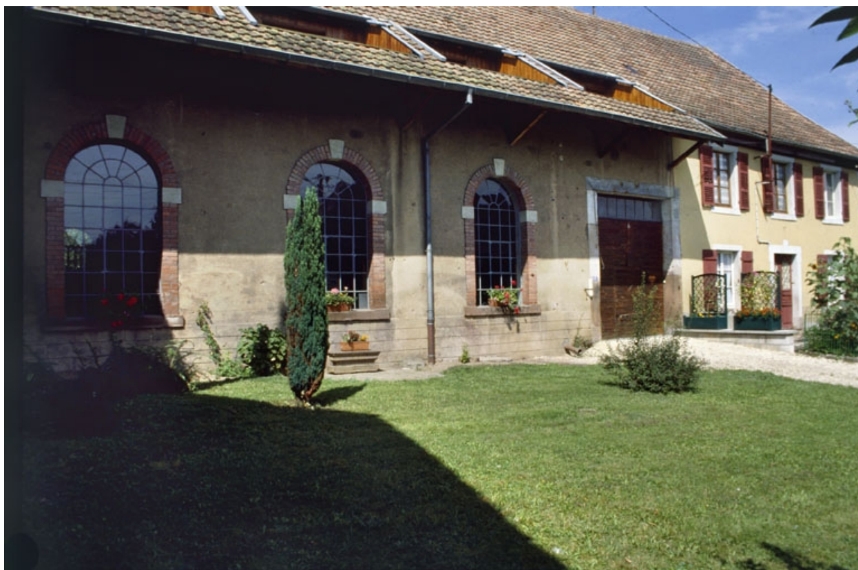
Façade de l'atelier mécanique.
