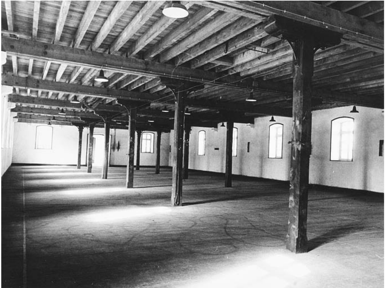
Etage du bâtiment B ou C.
