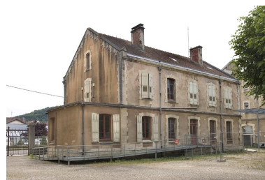
Façade postérieure du bâtiment des bureaux. Phot. Jérôme Mongreville IVR43_20097000613NUC2A
