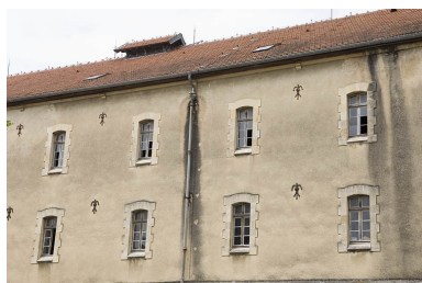
Etages supérieurs du corps central. Phot. Jérôme Mongreville IVR43_20097000615NUC2A
