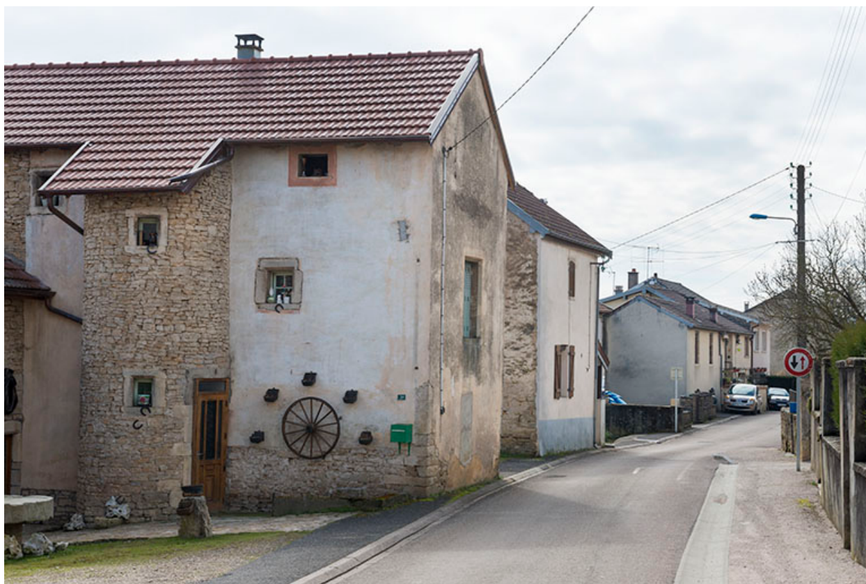
Ferme en équerre dotée d'une tour.
