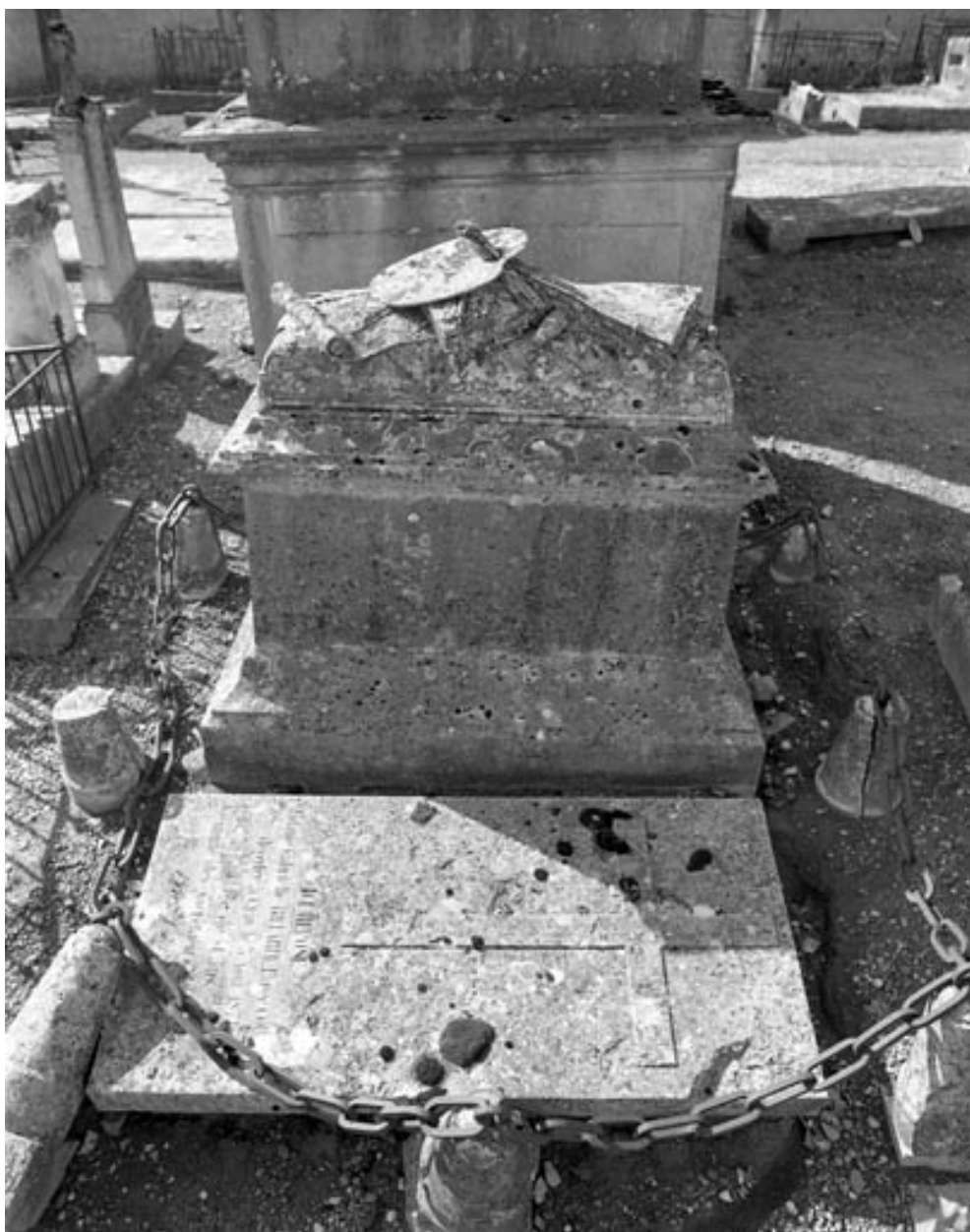
Façade droite, en plongée.
