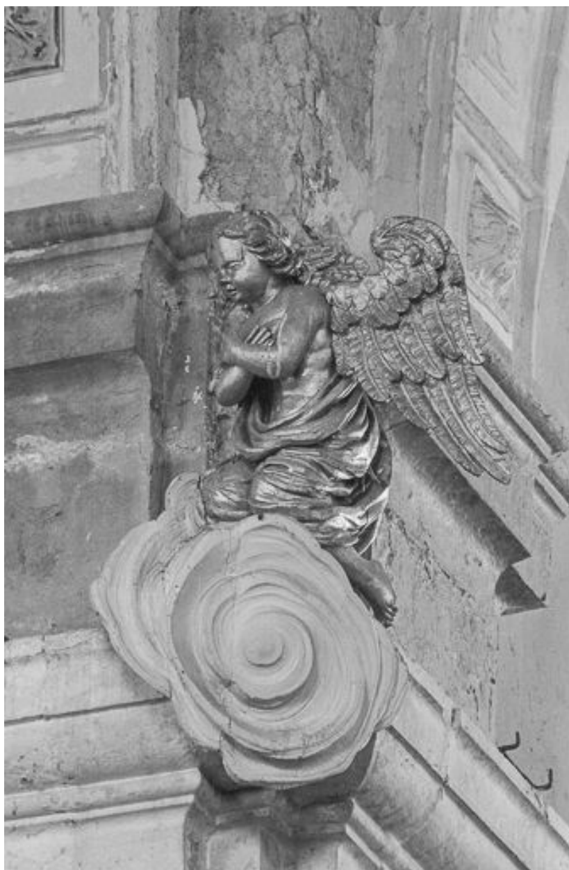
Ange de la corniche du pilastre droit.
