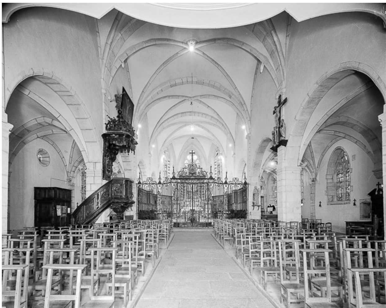
Intérieur : nef et choeur vus depuis l'entrée.
