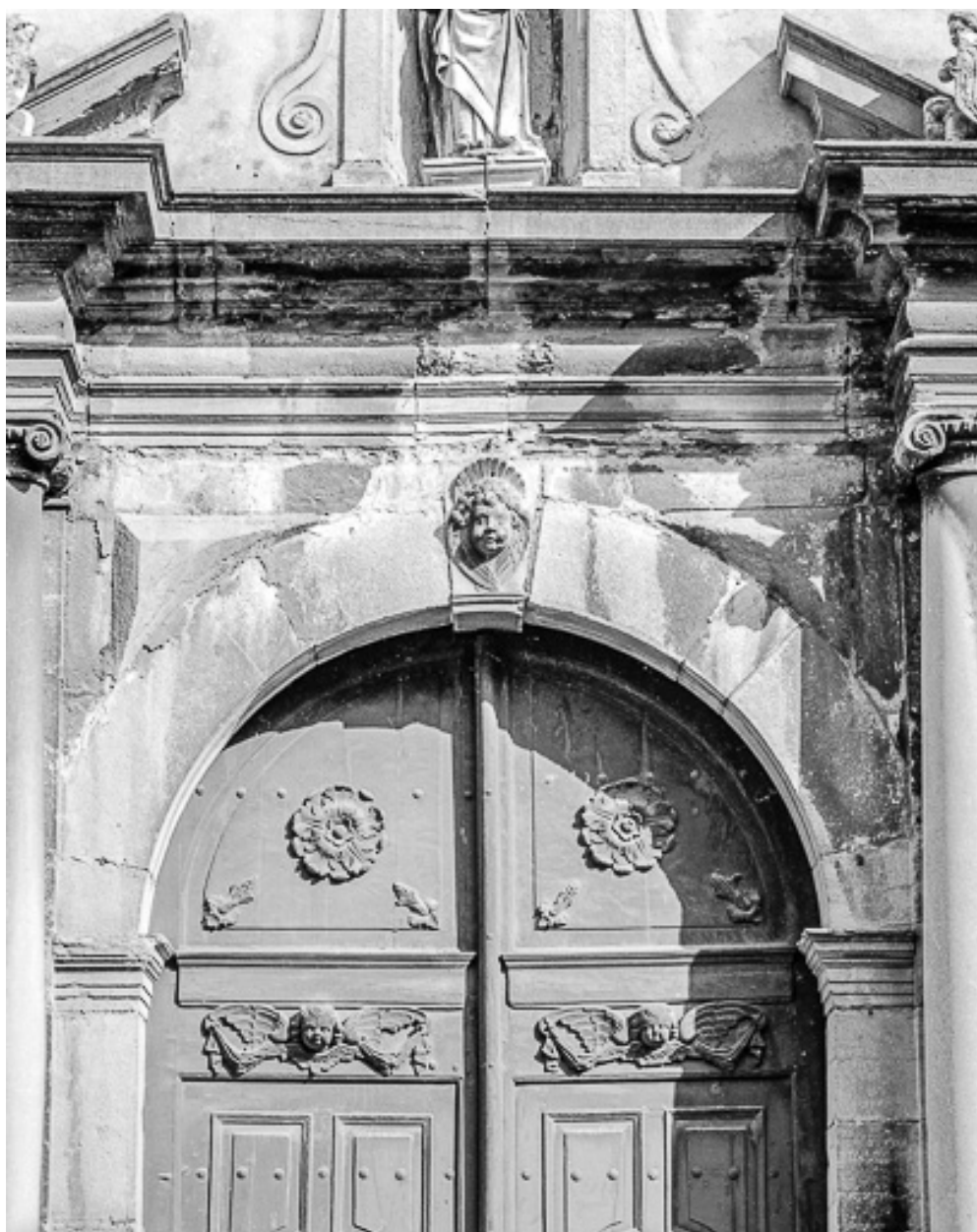
Portail de la façade antérieure : : partie supérieure.
