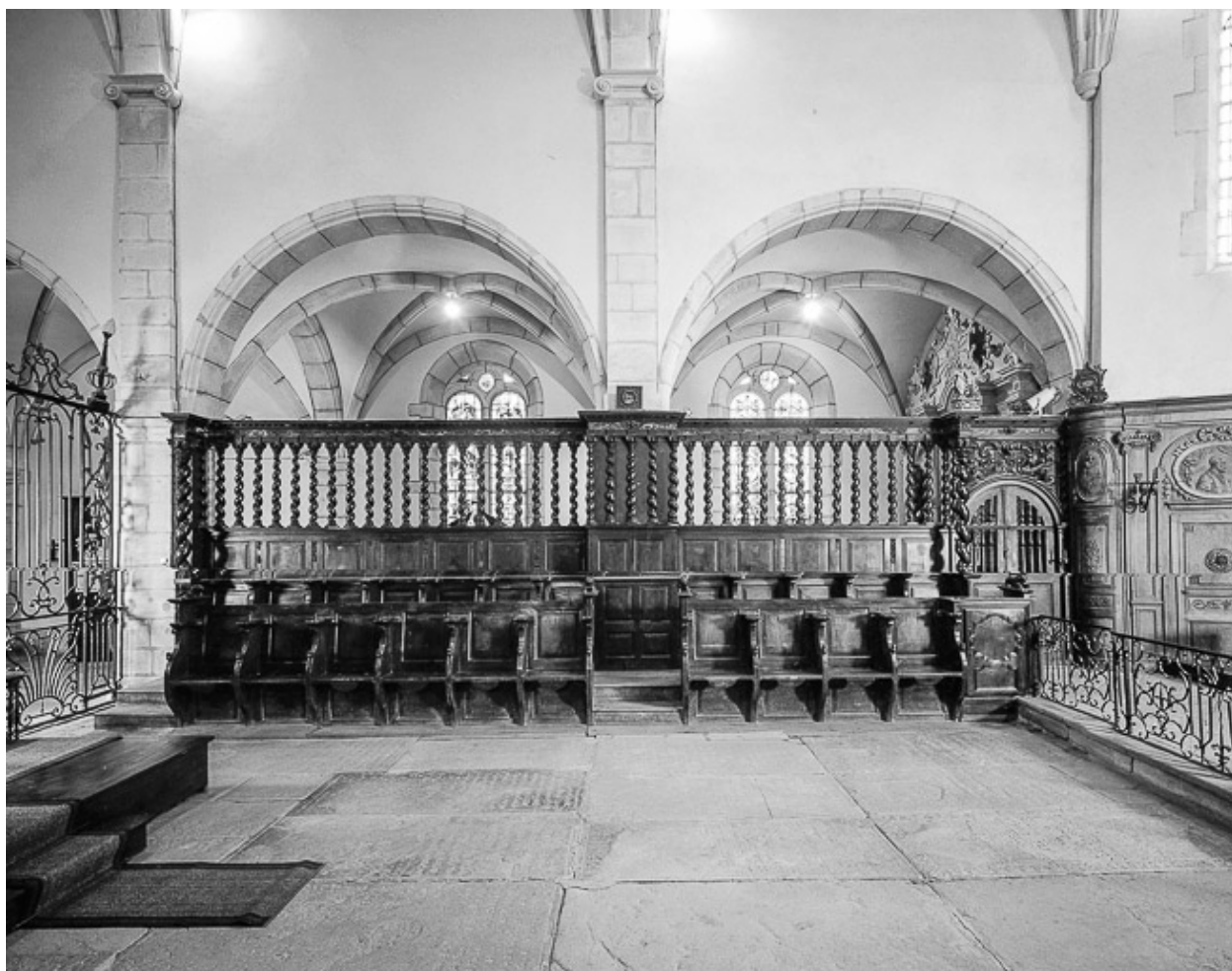
Intérieur : avant-choeur élévation gauche.
