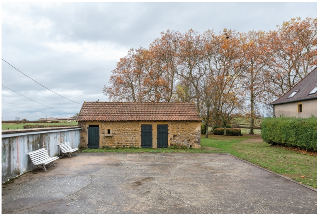
Ancien bâtiment à cochons
