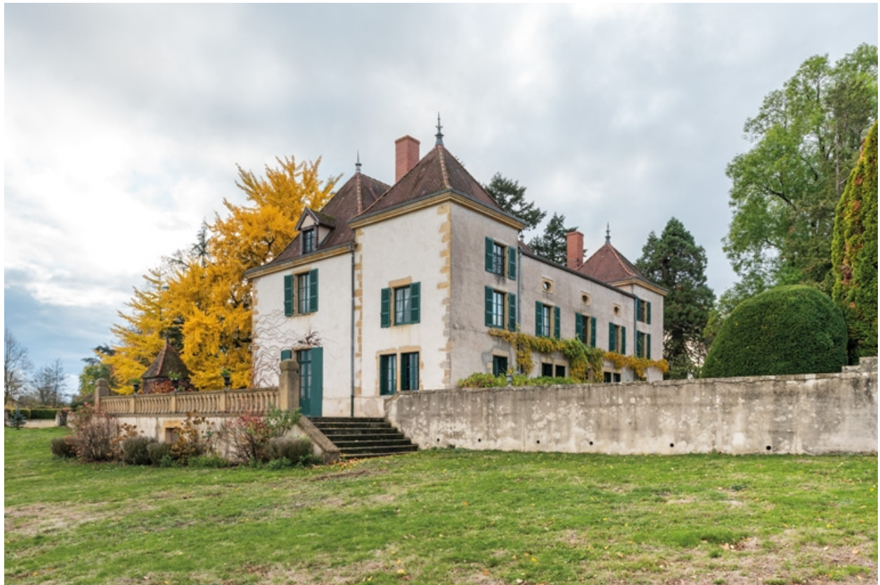
Château : vue de l'est
