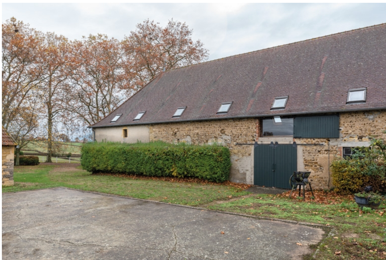
Façade antérieure de la grange
