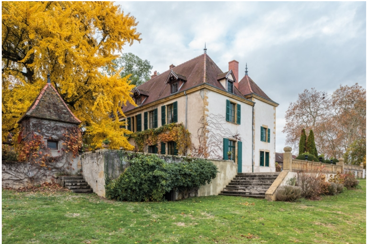
Château : vue de l'est
