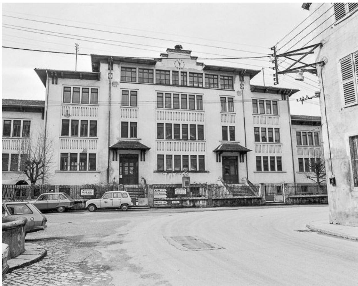
Vue d'ensemble (bâtiment détruit).
