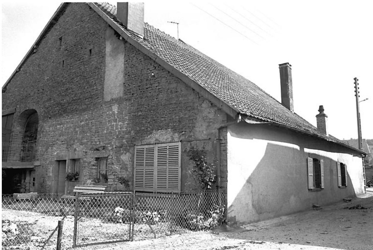
Façade postérieure et face latérale gauche.
