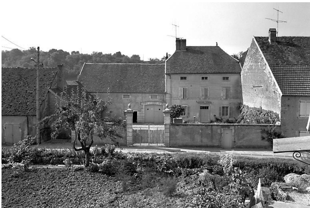
Ferme située 34 rue du Canal.
