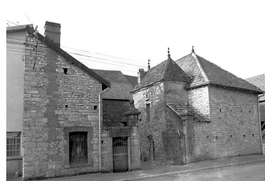
Ferme située 17-19 rue de la Gare. Phot. Bernard Lardière IVR43_19757000120X
