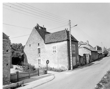
Maison située 26 rue du Canal. Phot. Dominique Dominguez IVR43_19807000447X
