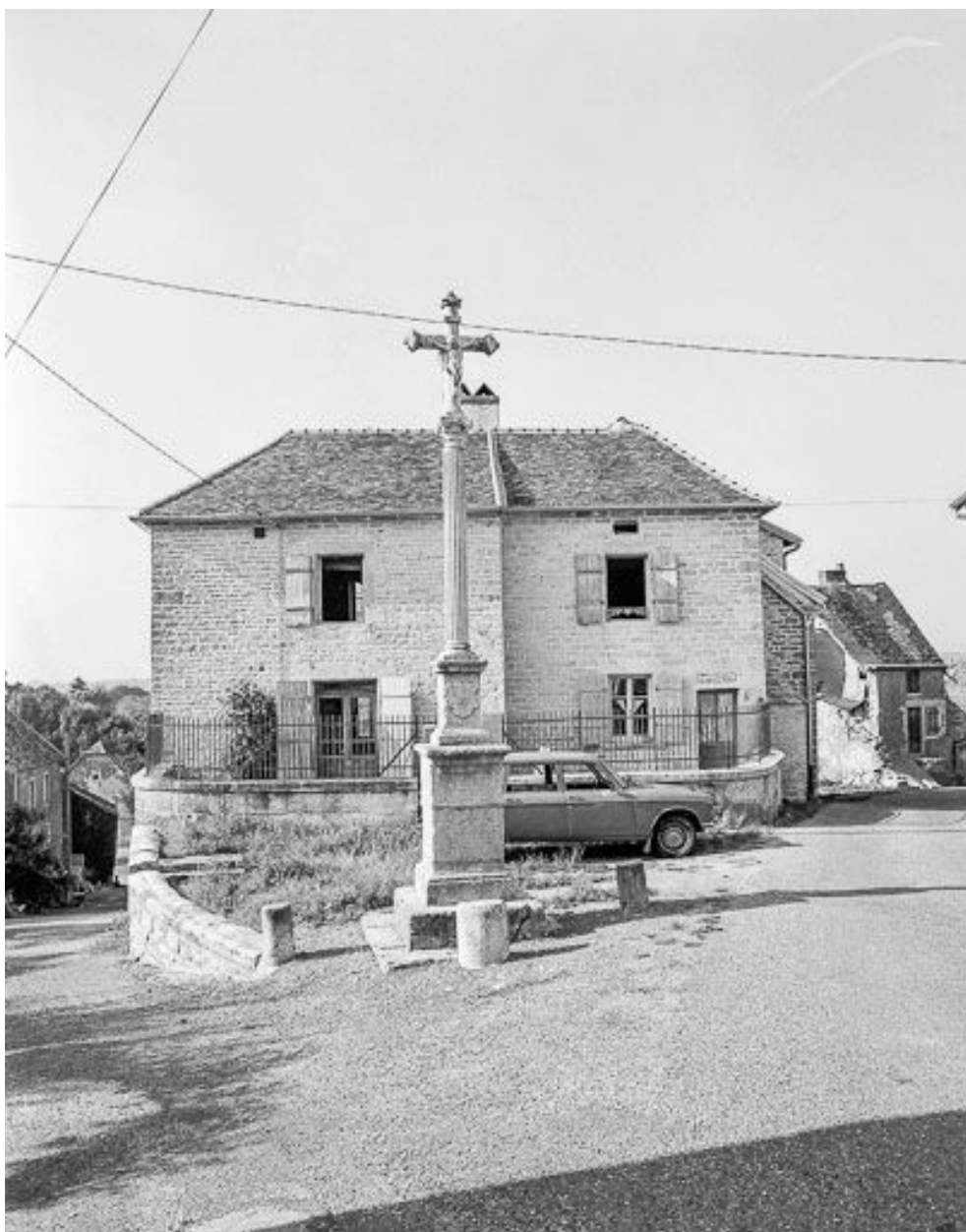
Maison située 1 rue du Mont.
