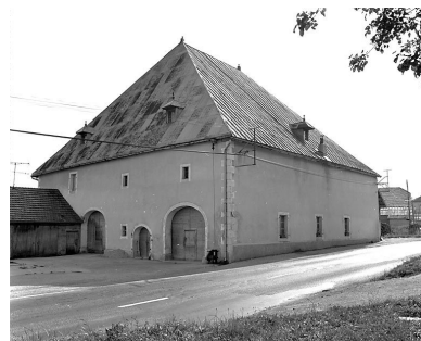
Ferme située 35 rue Principale. Phot. Yves Sancey IVR43_19782500507X
