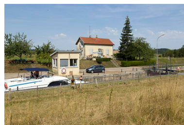
Bateau en train de franchir l'écluse. Phot. Sonia Dourlot IVR43_20157000794NUC2A
