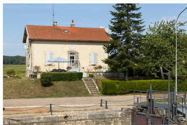
La maison d'éclusier. Phot. Sonia Dourlot IVR43_20157000795NUC2A
