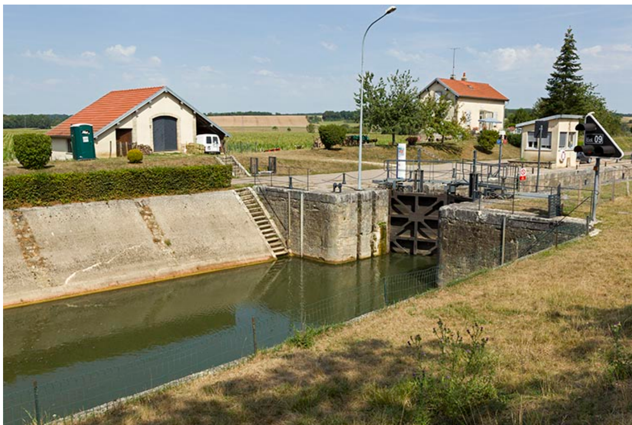
Entrée de l'écluse à sas.
