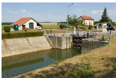
Entrée de l'écluse à sas. Phot. Sonia Dourlot IVR43_20157000793NUC2A
