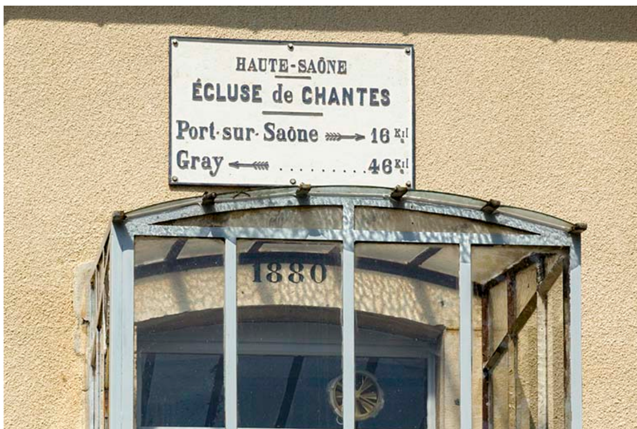
Plaque signalétique de l'écluse.
