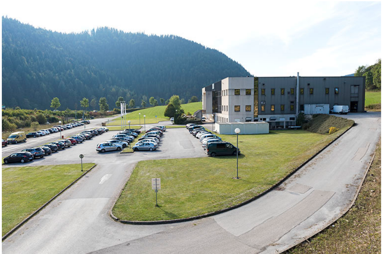
Façade latérale droite et stationnement.
