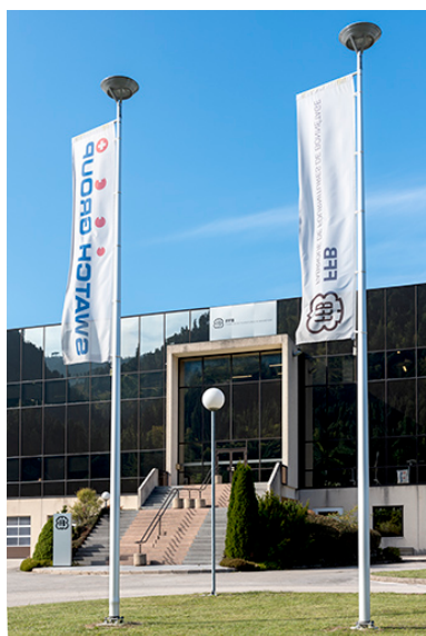
Façade antérieure : entrée monumentale. Phot. Sonia Dourlot IVR43_20162501264NUC4A
