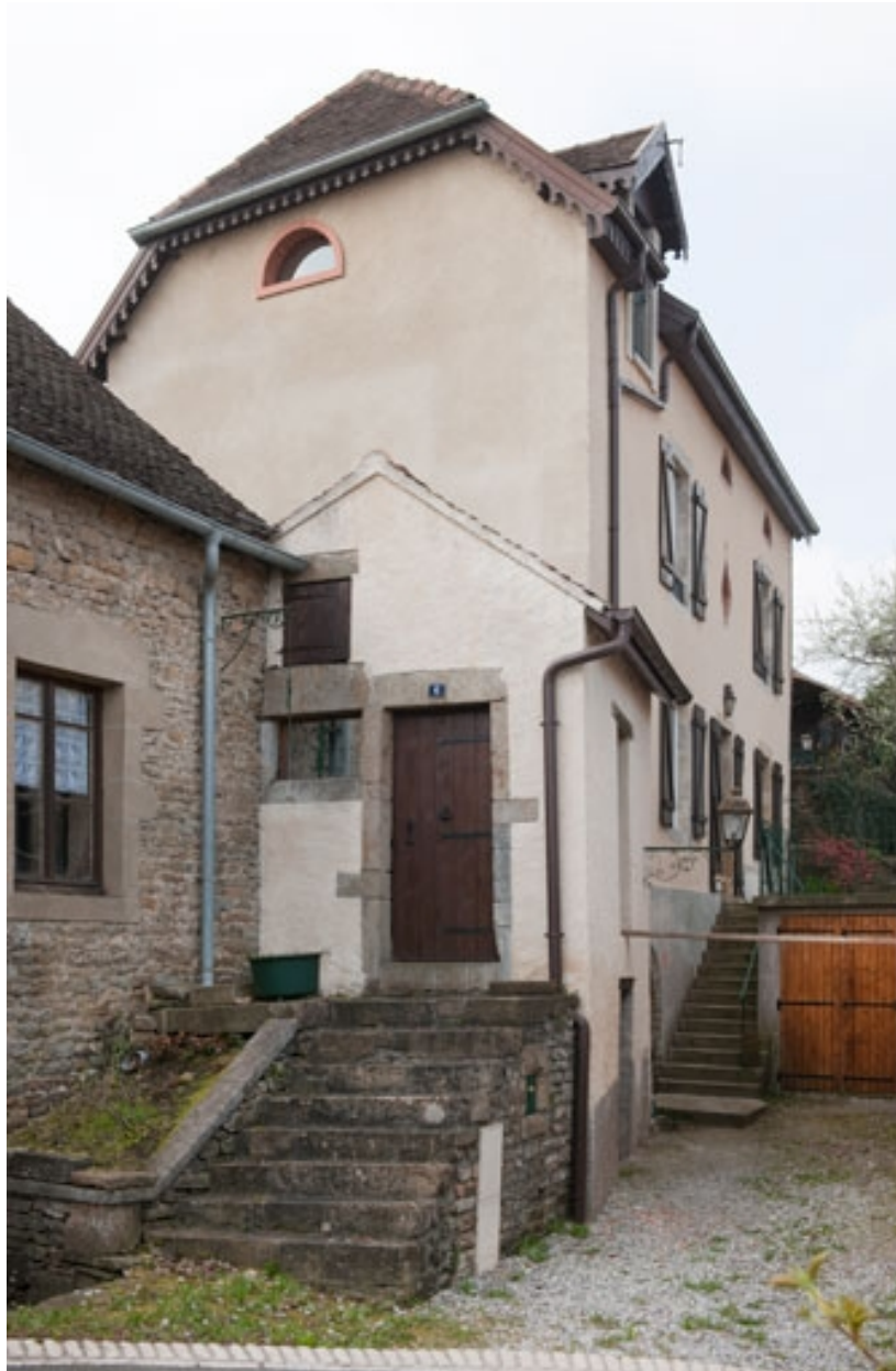
Habitation : façade latérale gauche et façade antérieure.
