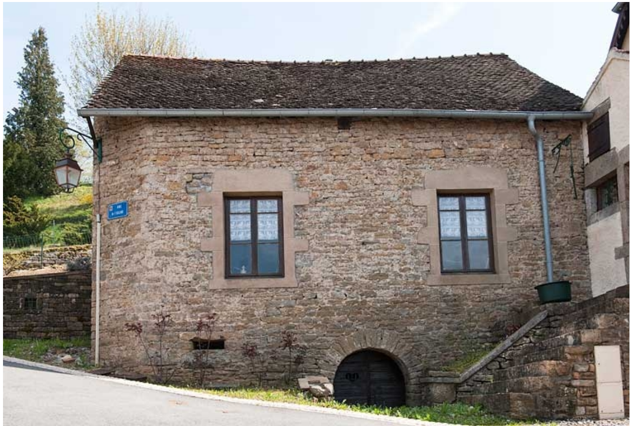
Grange : façade antérieure.
