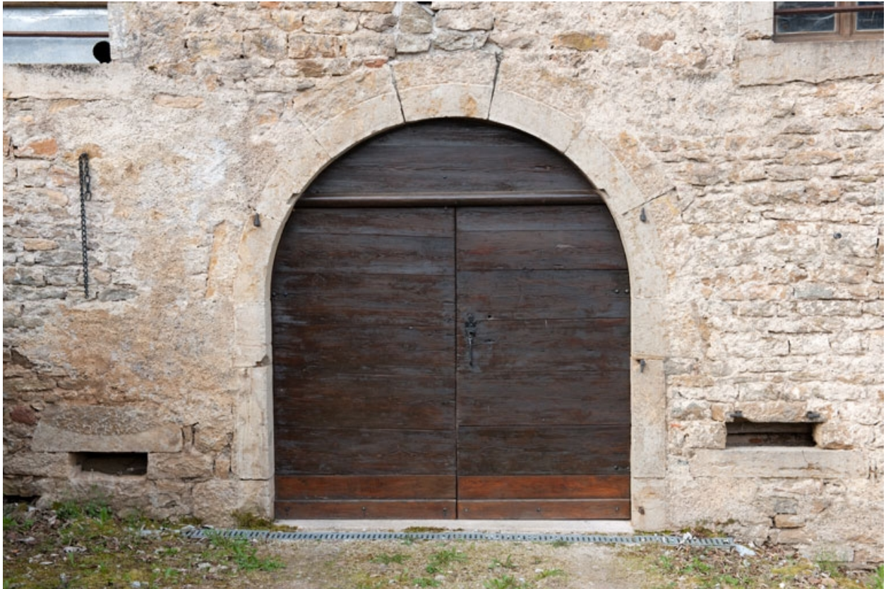
Grange : porte sur la façade latérale gauche.
