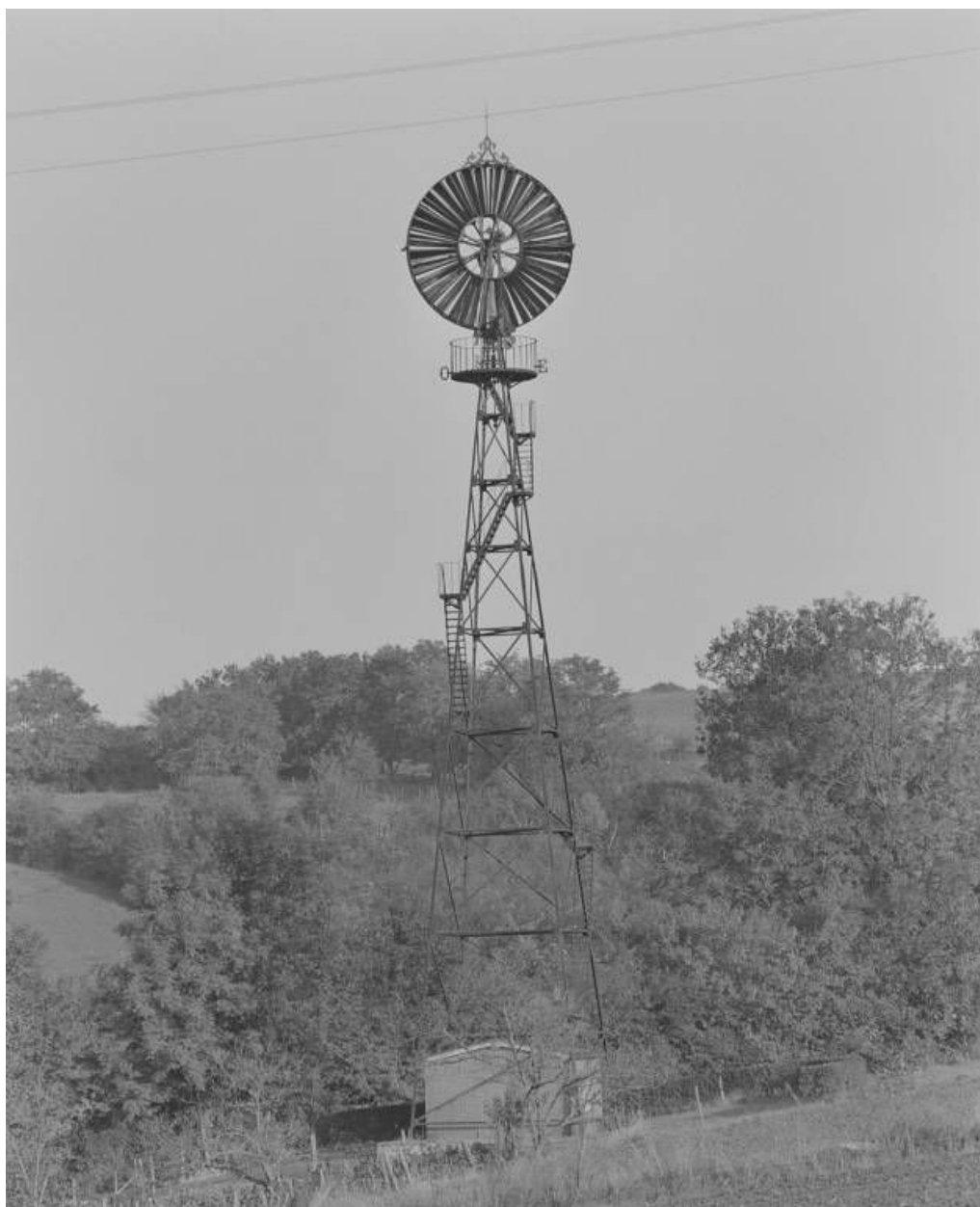
Vue d'ensemble prise du sud-est.
