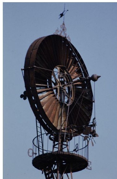
Vue d'ensemble prise de l'est. Phot. Jean-Luc Duthu IVR26_19925800293ZA
