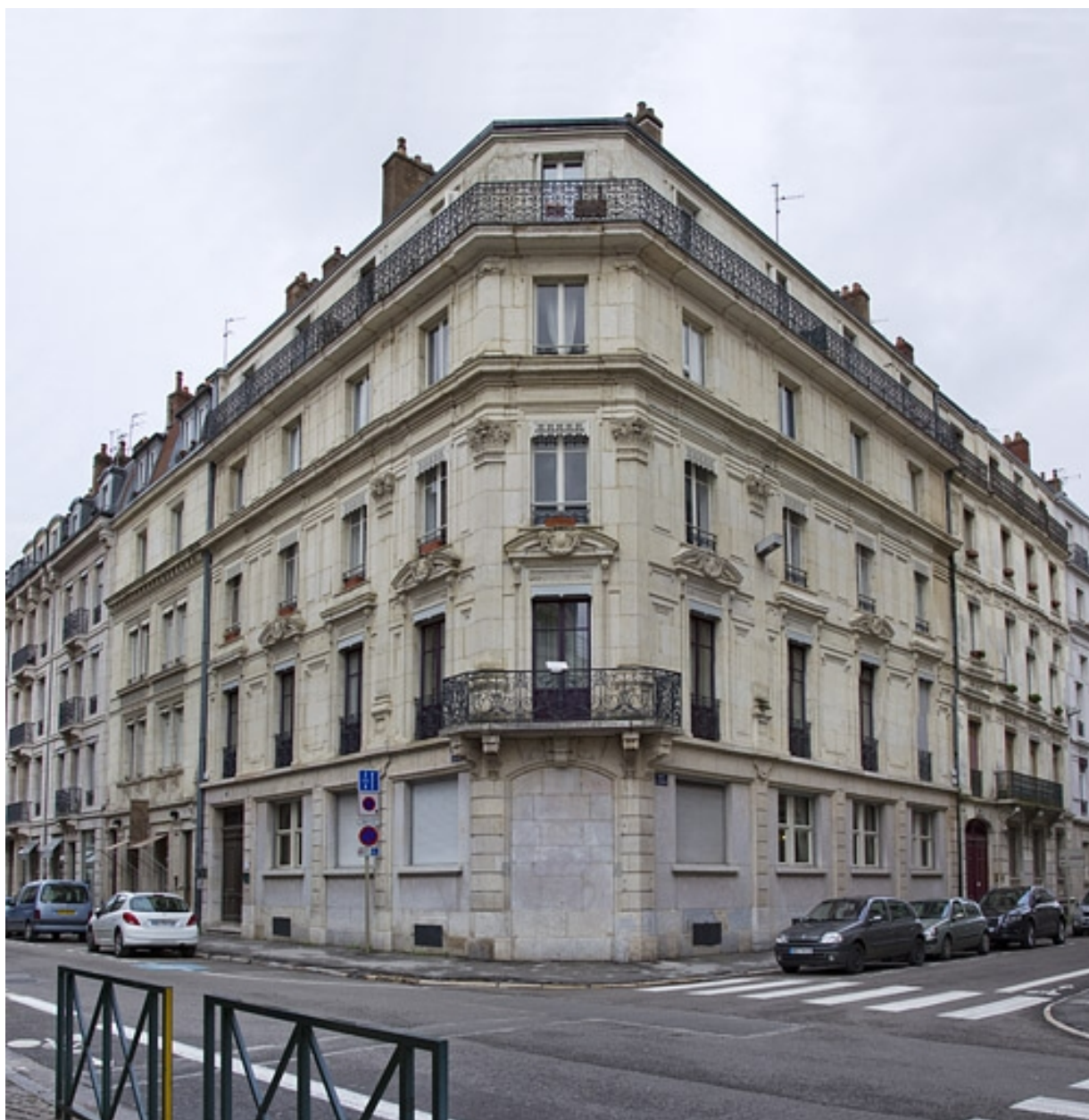
Vue d'ensemble depuis la rue.
