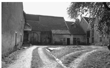
Ferme située impasse du Lavoir. Phot. Bernard Lardière IVR43_19797000107Z
