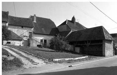
Ferme située 6 Grande Rue. Phot. Bernard Lardière IVR43_19797000112Z
