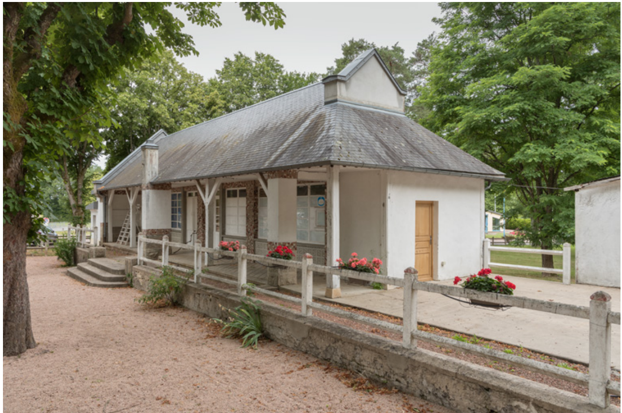
Club-house, vue d'ensemble.
