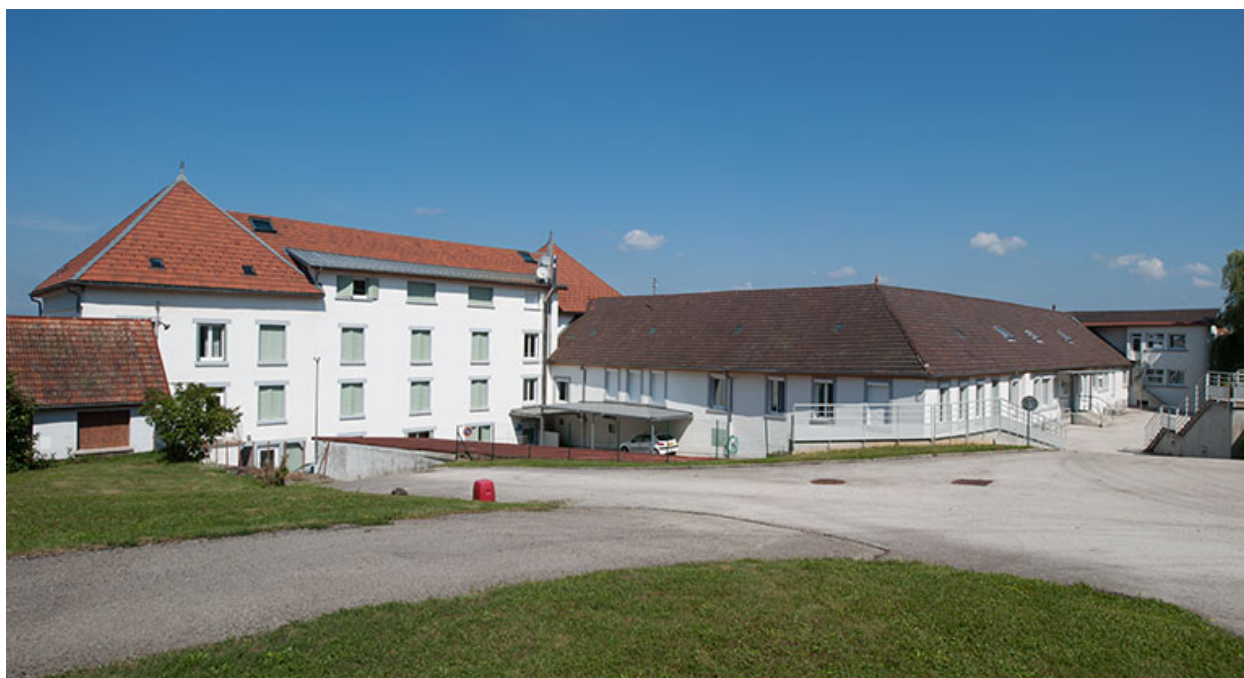
Cour et façade postérieure des bâtiments d'externat.
