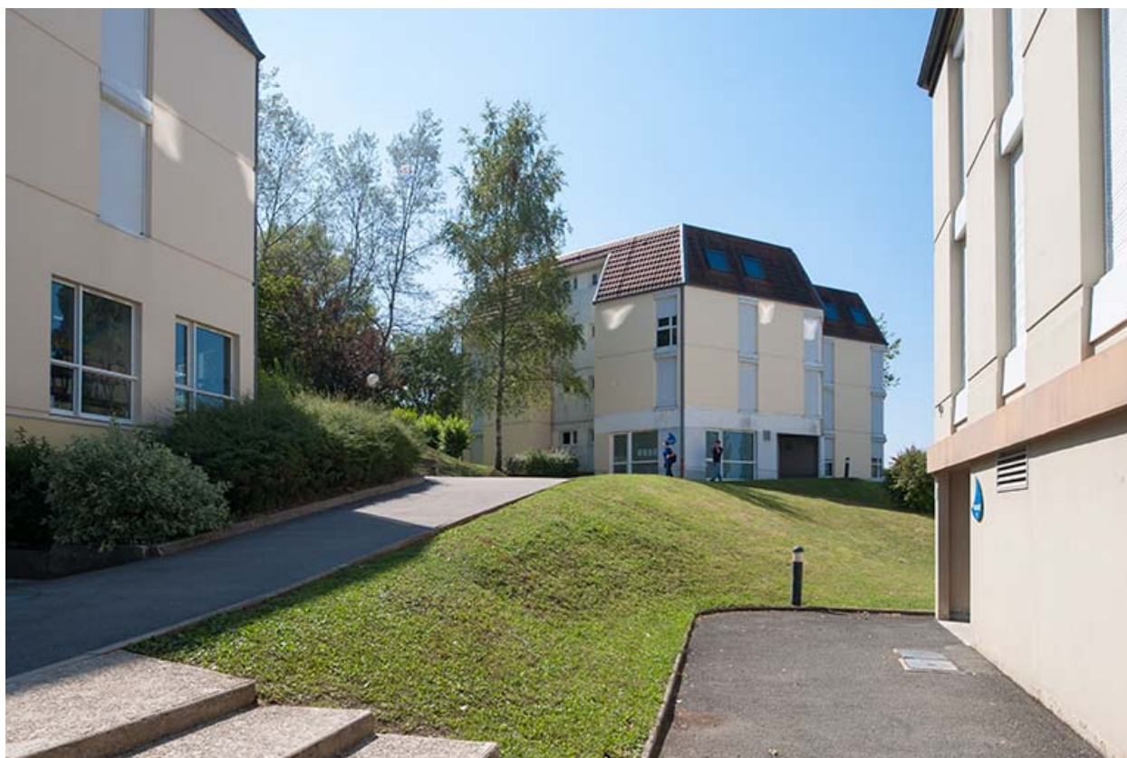
Les bâtiments d'hébergement.
