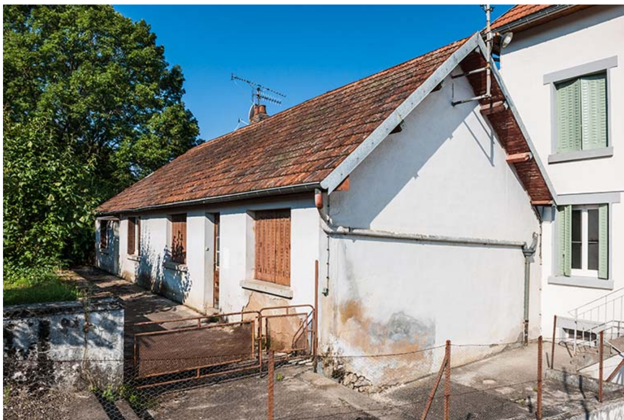
Angle est du logement.
