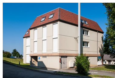
Bâtiment d'hébergement 3. Phot. Jérôme Mongreville IVR43_20132501587NUC4A
