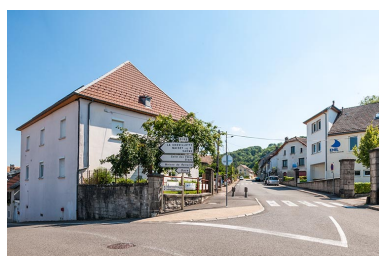
Angle ouest de l'annexe. Phot. Jérôme Mongreville IVR43_20132501612NUC4A
