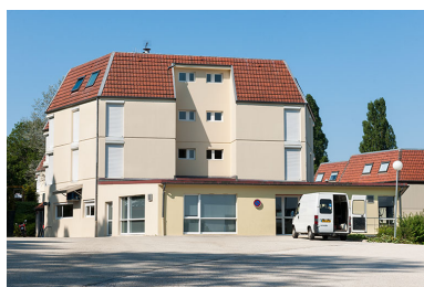
Bâtiment d'hébergement et de restauration. Phot. Jérôme Mongreville IVR43_20132501585NUC4A
