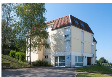
Bâtiment d'hébergement 2. Phot. Jérôme Mongreville IVR43_20132501586NUC4A
