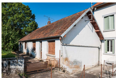
Angle est du logement.
