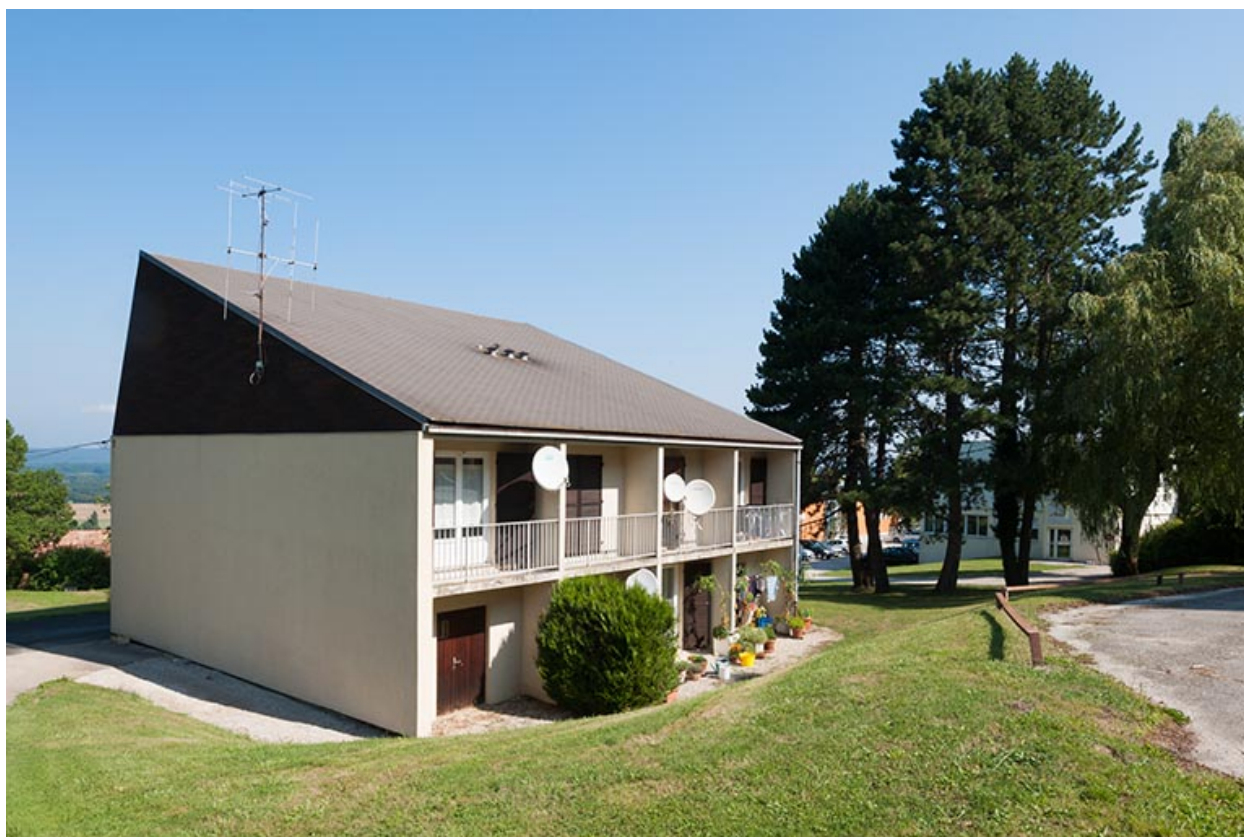
Angle sud des logements de fonction.
