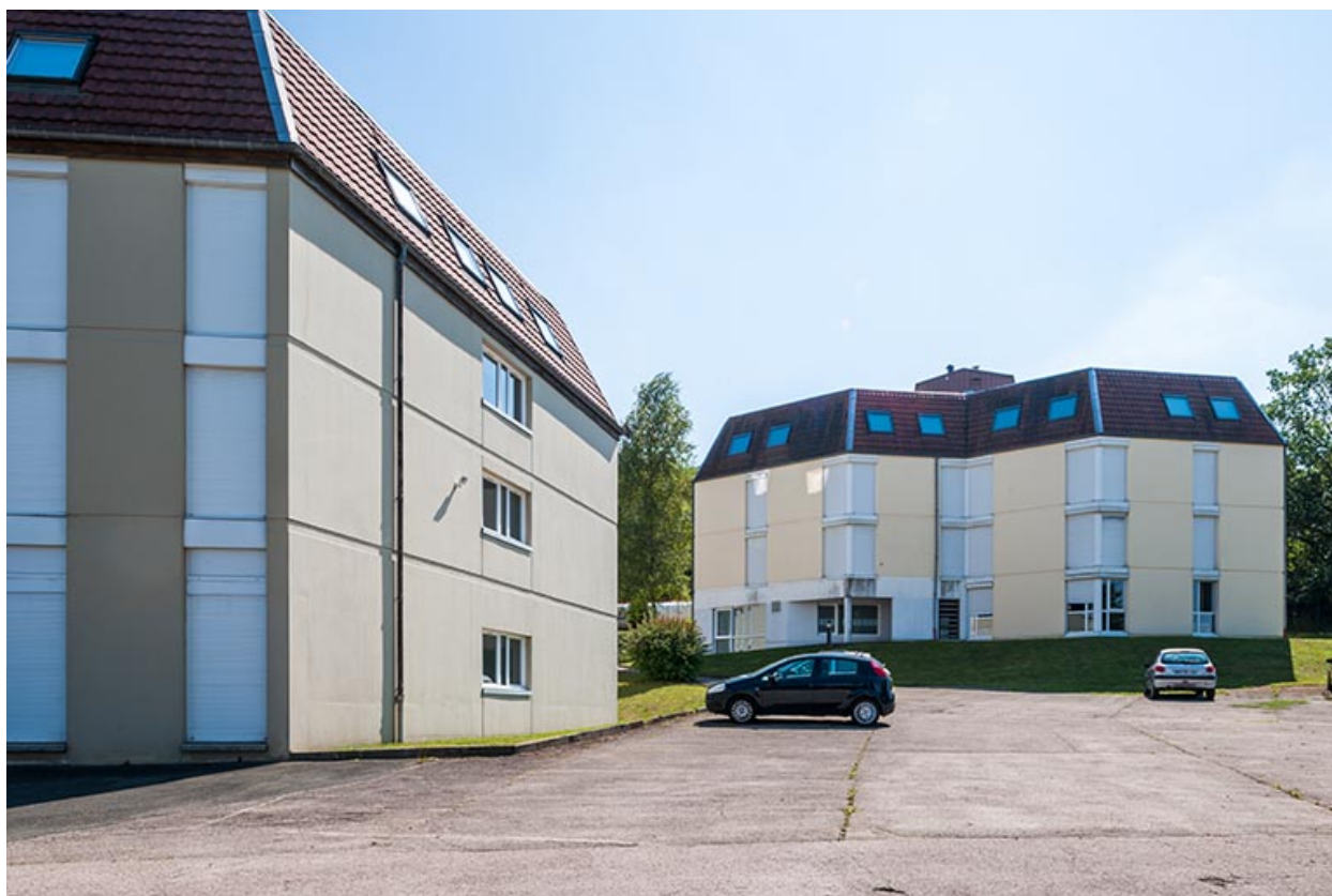
Les bâtiments d'hébergement.
