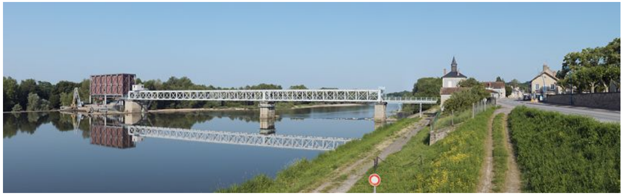
Vue d'ensemble du barrage.
