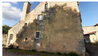
Vue de la l'élévation ouest, qui présente un linteau à double accolade en remploi ainsi que les fragments d'une arcade murée. Phot. Baptiste Quost IVR26_20232100288NUC2A
