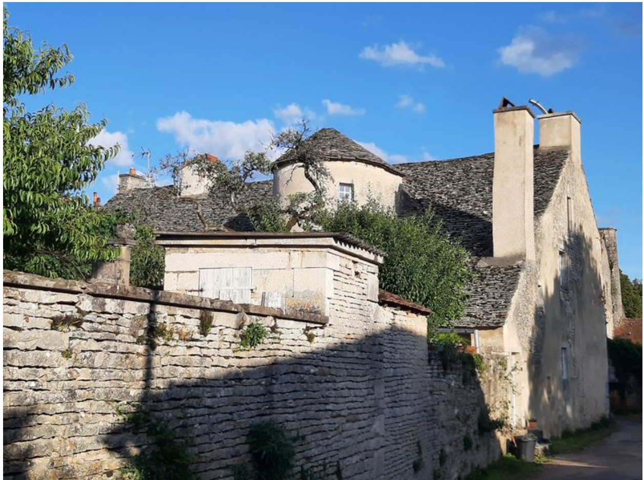
Vue de la demeure depuis le nord-ouest.
