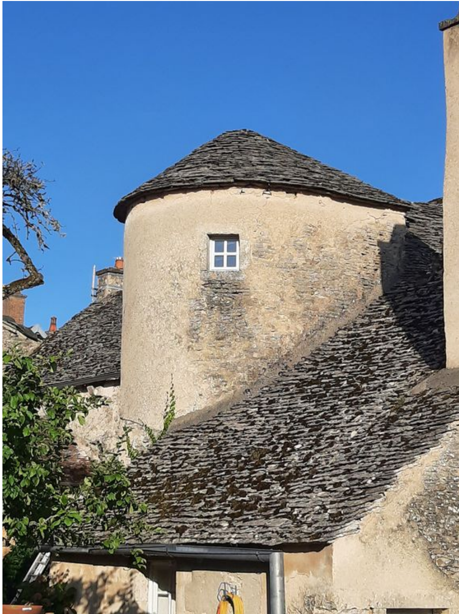
Détail du toit en lave et de la tour d'escalier hors-oeuvre.
