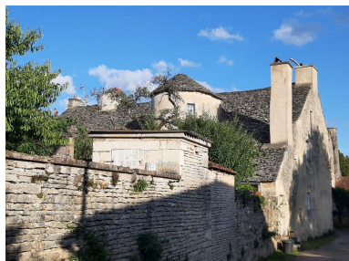
Vue de la demeure depuis le nord-ouest. Phot. Baptiste Quost IVR26_20232100286NUC2A
