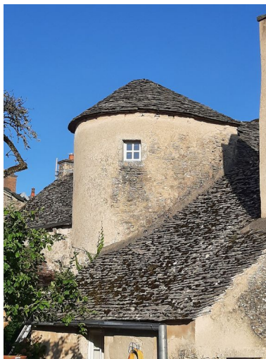
Détail du toit en lave et de la tour d'escalier hors-oeuvre. Phot. Baptiste Quost IVR26_20232100287NUC2A
