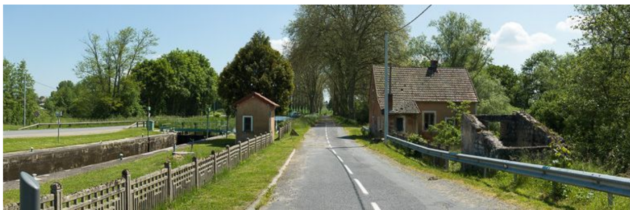
Vue d'ensemble depuis le pont sur écluse.
