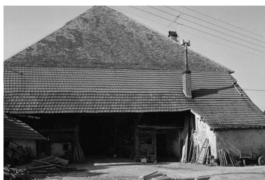
Façade latérale gauche. Phot. Gilbert Poinot IVR43_19752500842Z
