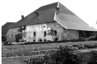
Vue de trois quarts droit. Phot. Gilbert Poinot IVR43_19752500841Z
