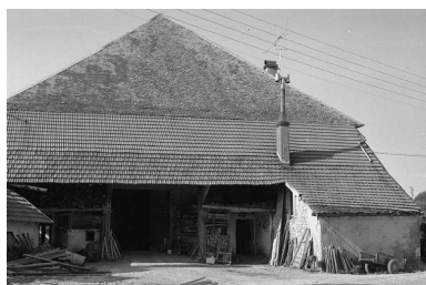
Façade latérale gauche. Phot. Gilbert Poinot IVR43_19752500843Z
