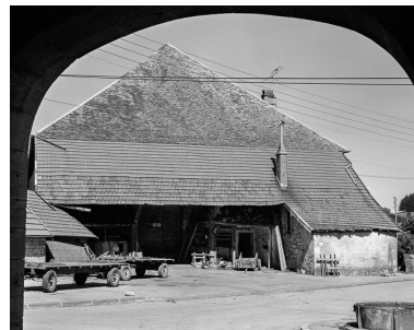
Façade latérale gauche. Phot. Bernard Lardière IVR43_19782500355X
